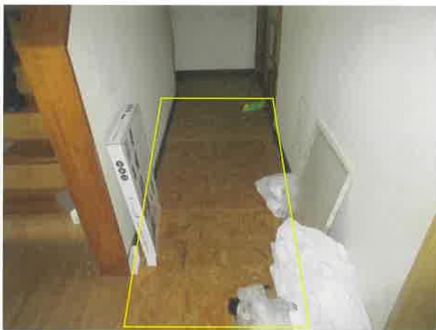
物件2:1階廊下床の状況(床に板を敷いている)
