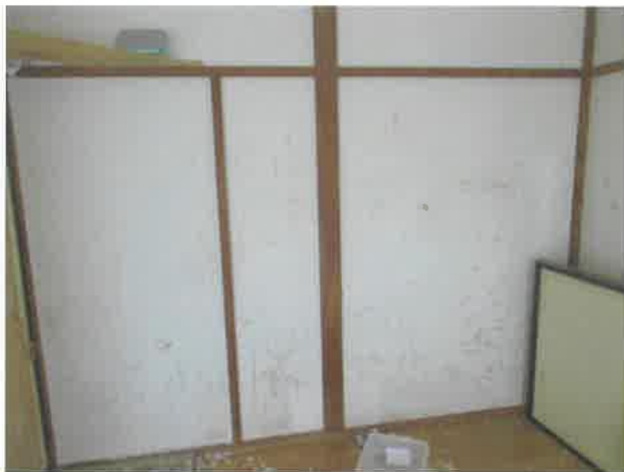
物件2:2階洋室の壁面の汚れ
