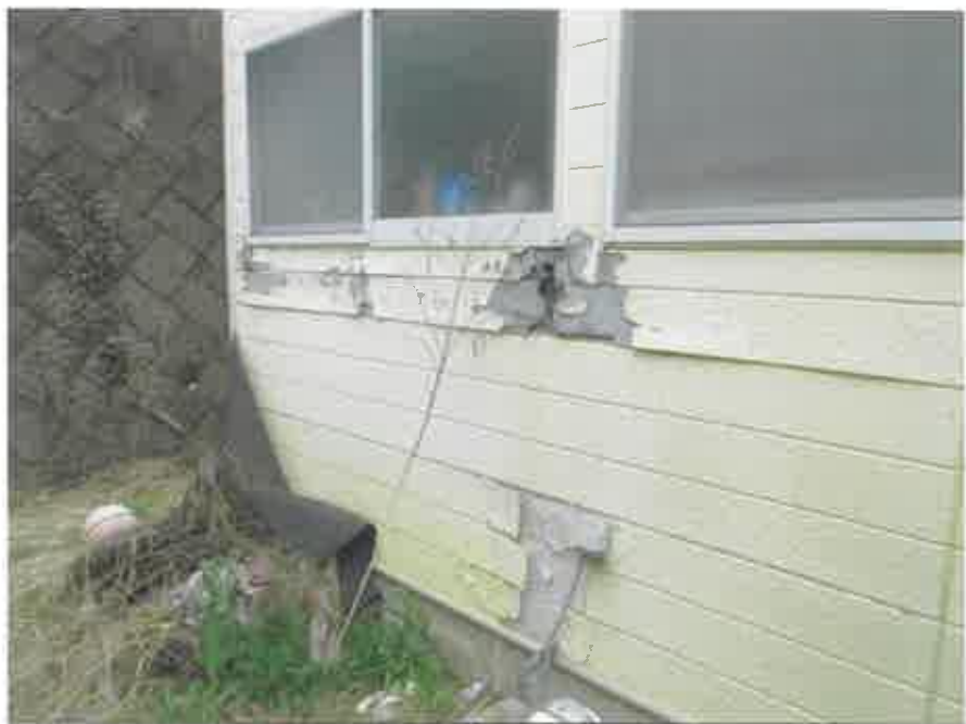
物件2:1階西側外壁の損傷状況
