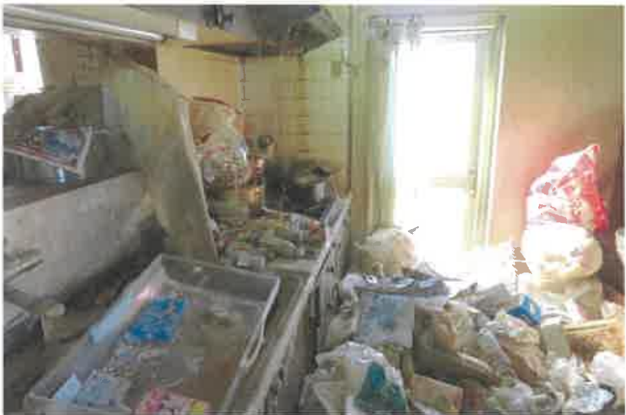
物件2:1階キッチンの状況
