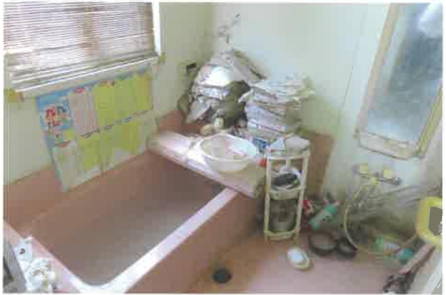
物件2:1階浴室の状況
