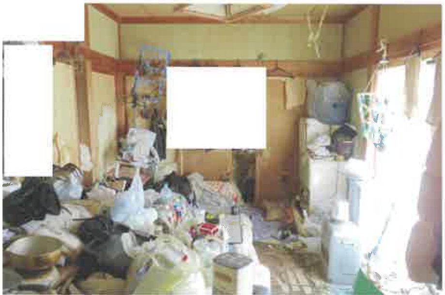
物件2:1階西側和室の状況
