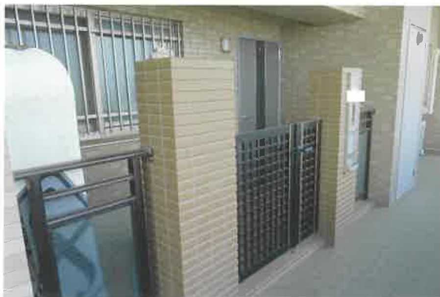
物件1:ポーチの状況
