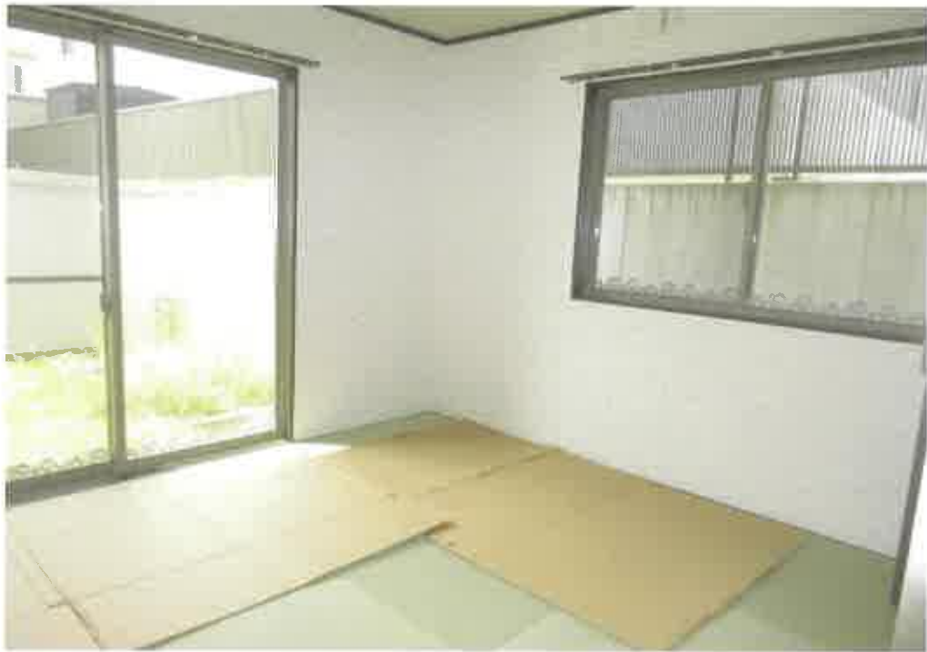
物件3:1階和室の状況
