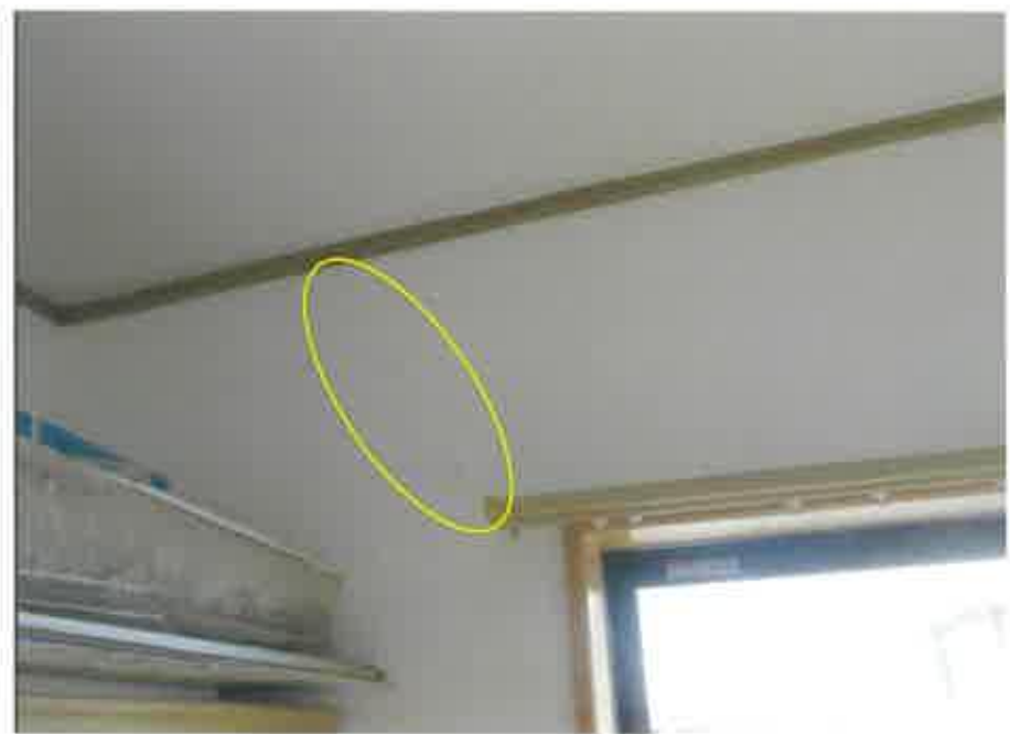
物件4:主である建物 2階洋室1壁面の亀裂
