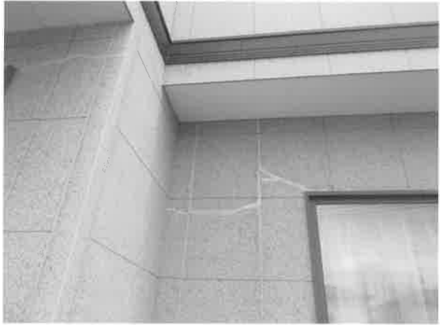
物件4:主である建物 外壁亀裂の補修跡
