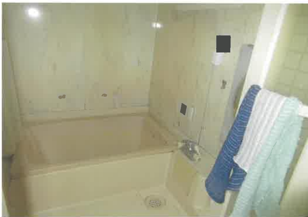
物件3:1階浴室の状況
