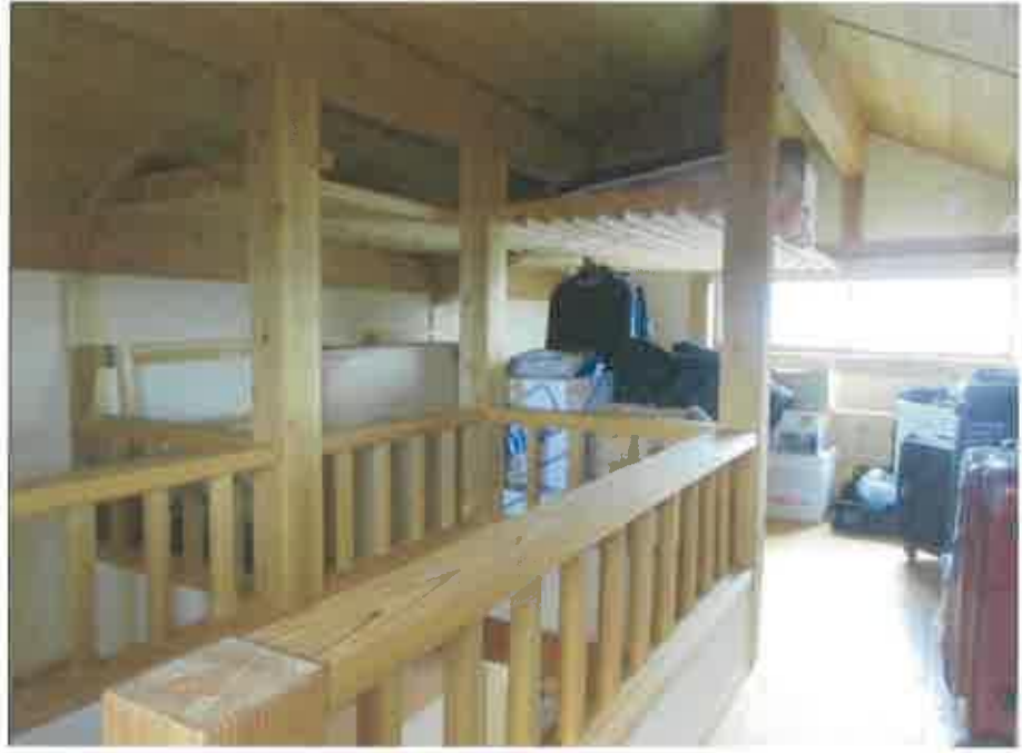
物件2:2階 小屋裏収納の状況
