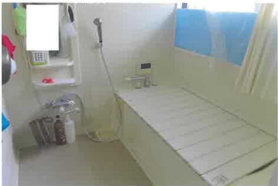
物件3:2階浴室の状況
