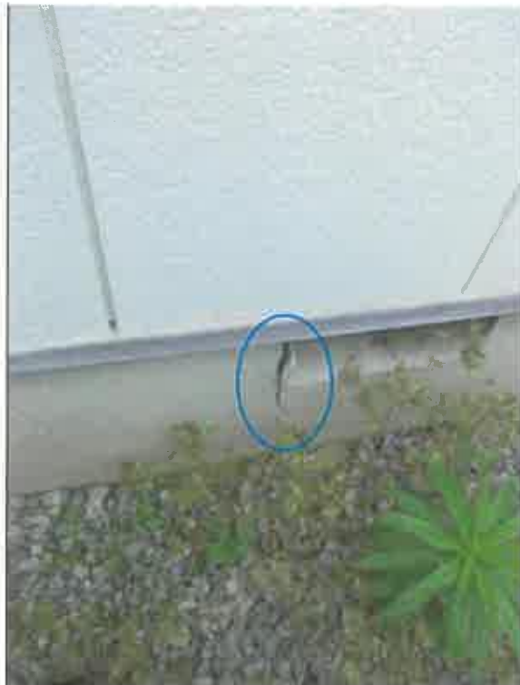
物件2:北側基礎部分の亀裂
