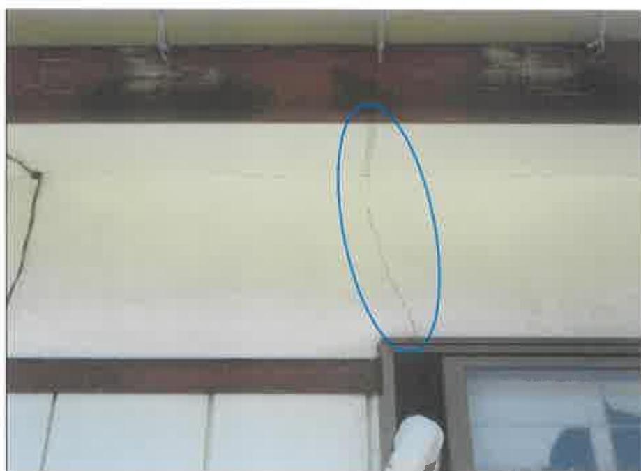
物件2:南側外壁上部の亀裂
