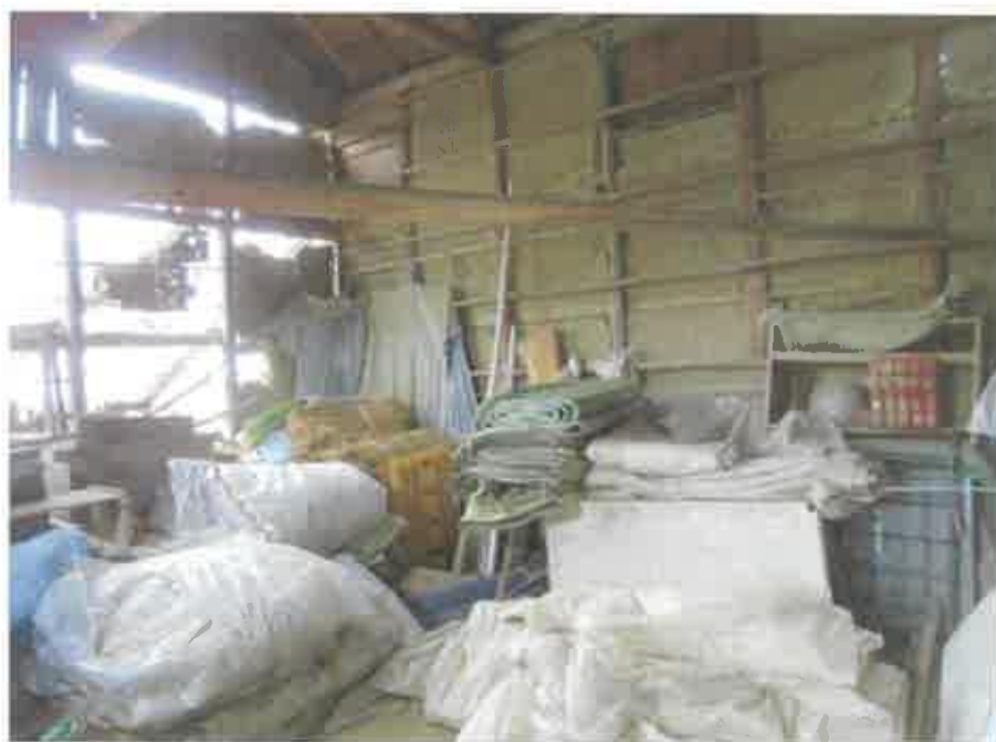
物件2:附属建物符号5 内部の状況
