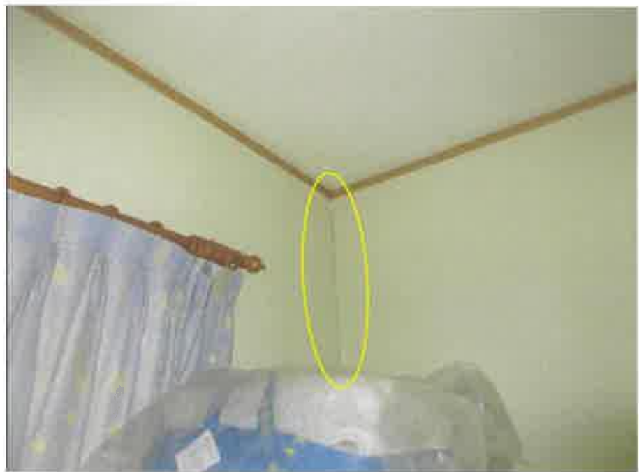
物件3:洋室②壁の状況
