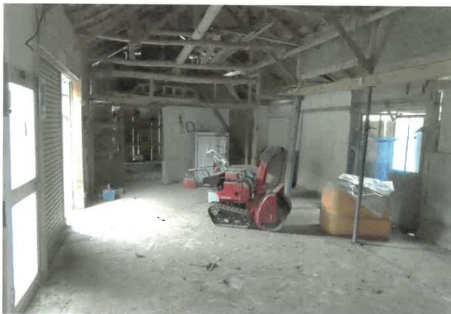
物件2附属建物符号2の内部の状況
