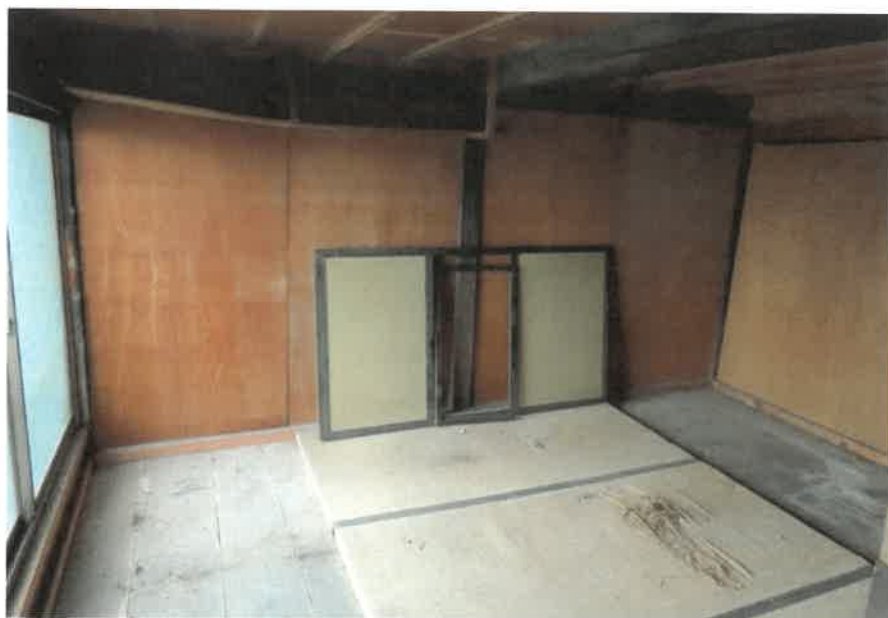
物件2主である建物: 既存部分2階和室の状況
