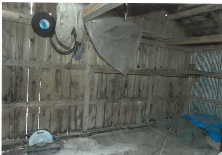
物件2附属建物符号2の内部の状況
