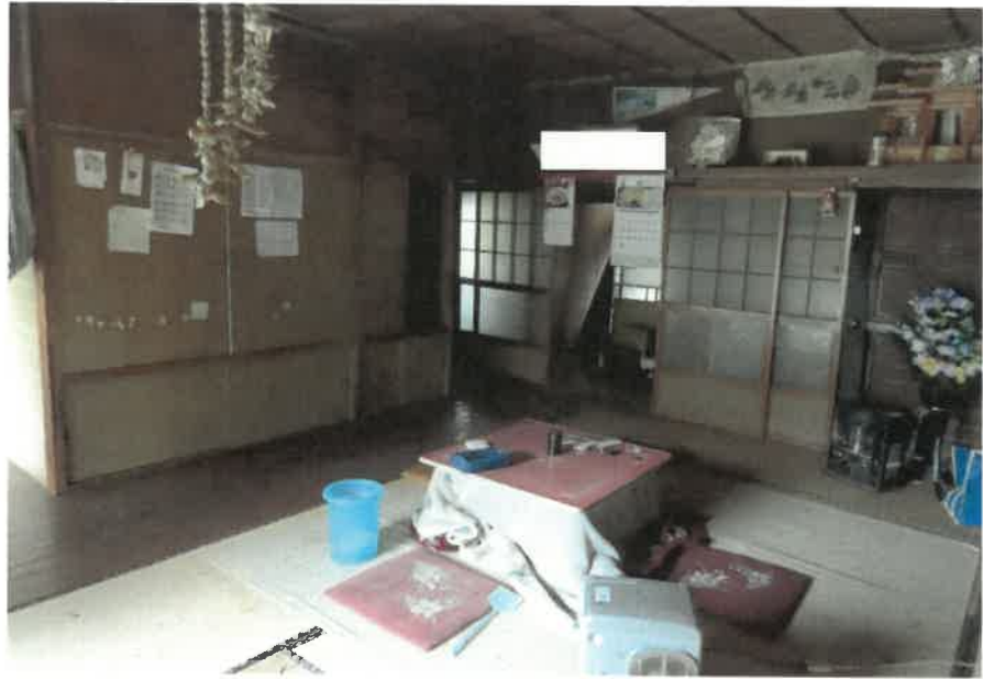
物件2主である建物:既存部分1階和室(畳)の状況
