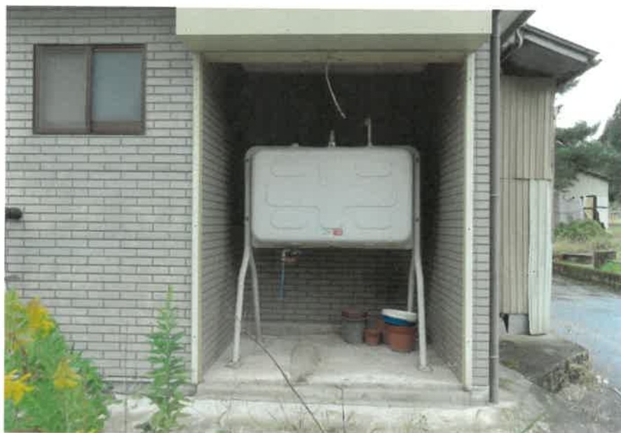
物件2主である建物: 1階増築部分タンク置き場の状況
