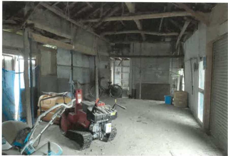
物件2附属建物符号2の内部の状況
