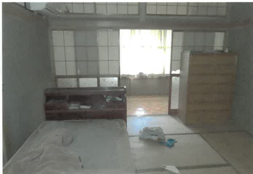
物件2主である建物:増築部分2階東側和室の状況
