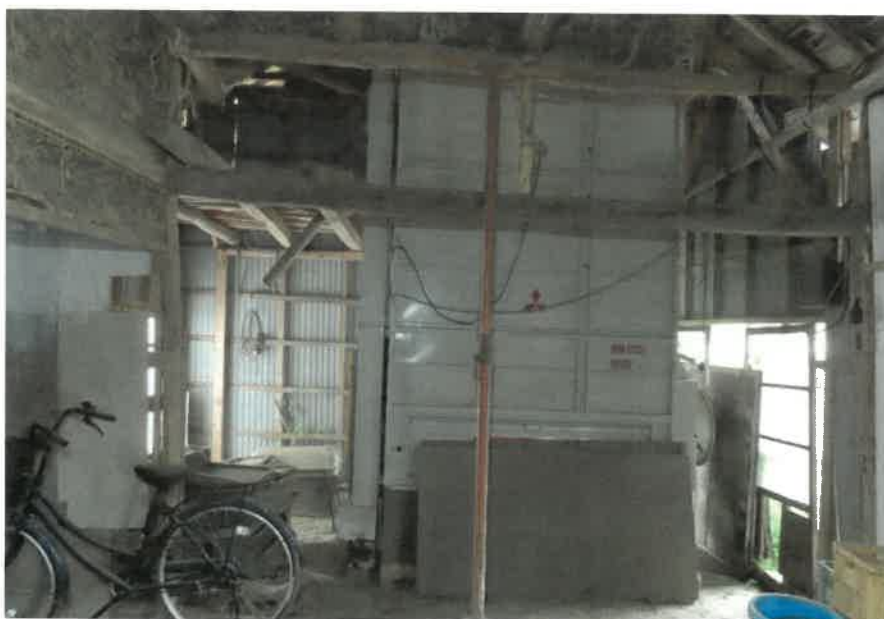
物件2附属建物符号2の内部の状況
