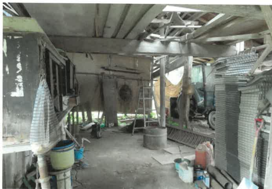
物件2附属建物符号1の内部の状況
