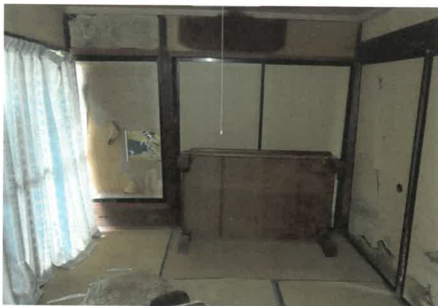
物件2主である建物:既存部分1階北東側和室の状況
