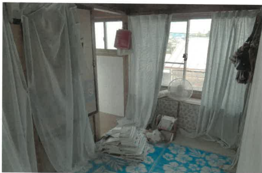
物件2:2階西側和室の状況
