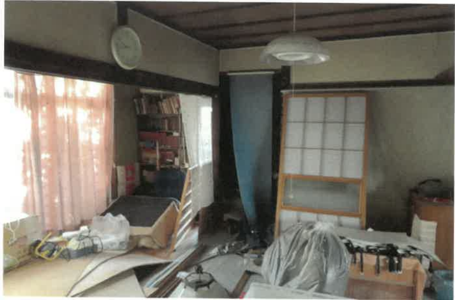
物件2:1階西側和室の状況
