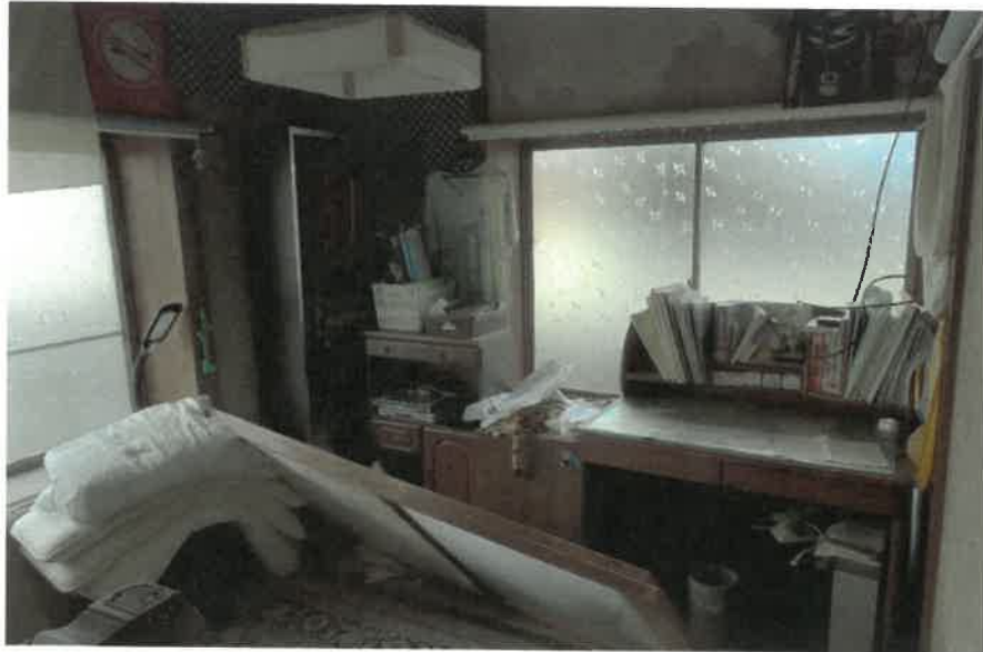
物件2:1階北東側和室の状況
