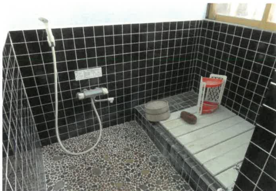
物件2:1階浴室の状況
