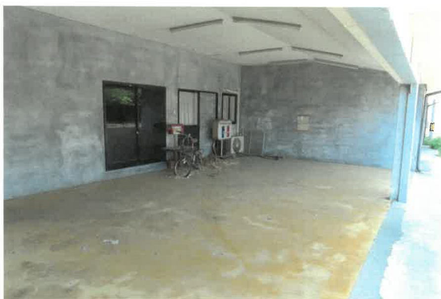
物件2:車庫の状況
