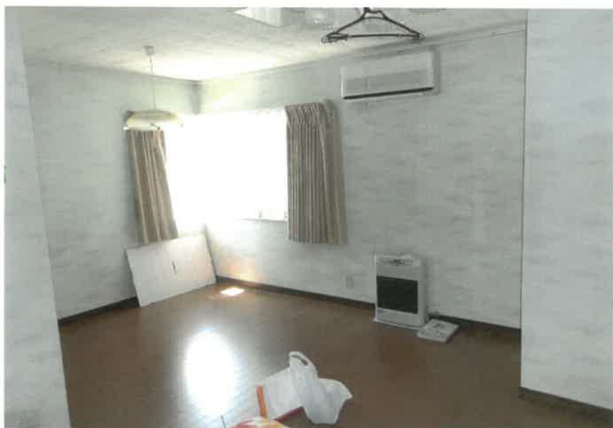
物件2:1階洋室の状況
