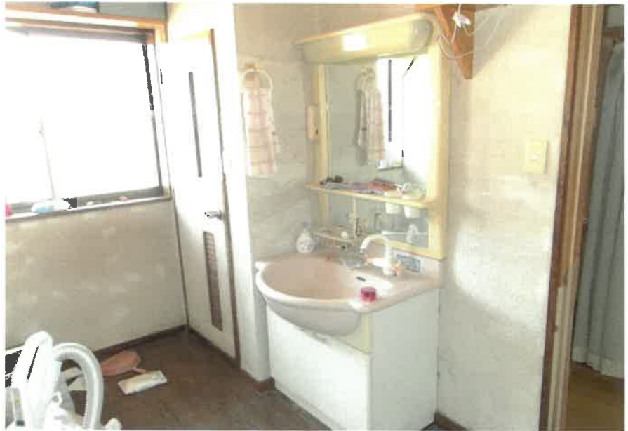
物件2:2階トイレ洗面台の状況
