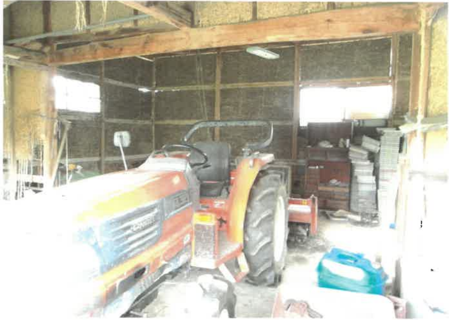
物件5未登記附属建物:車庫・物置の状況
