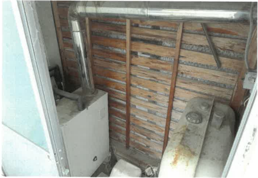
物件2主である建物:ボイラ室の状況
