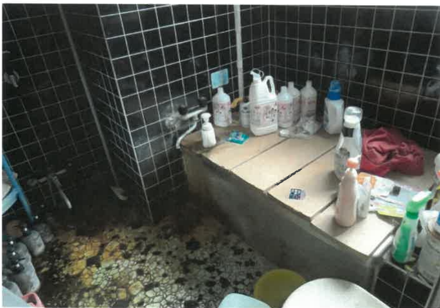
物件2主である建物:1階浴室状況
