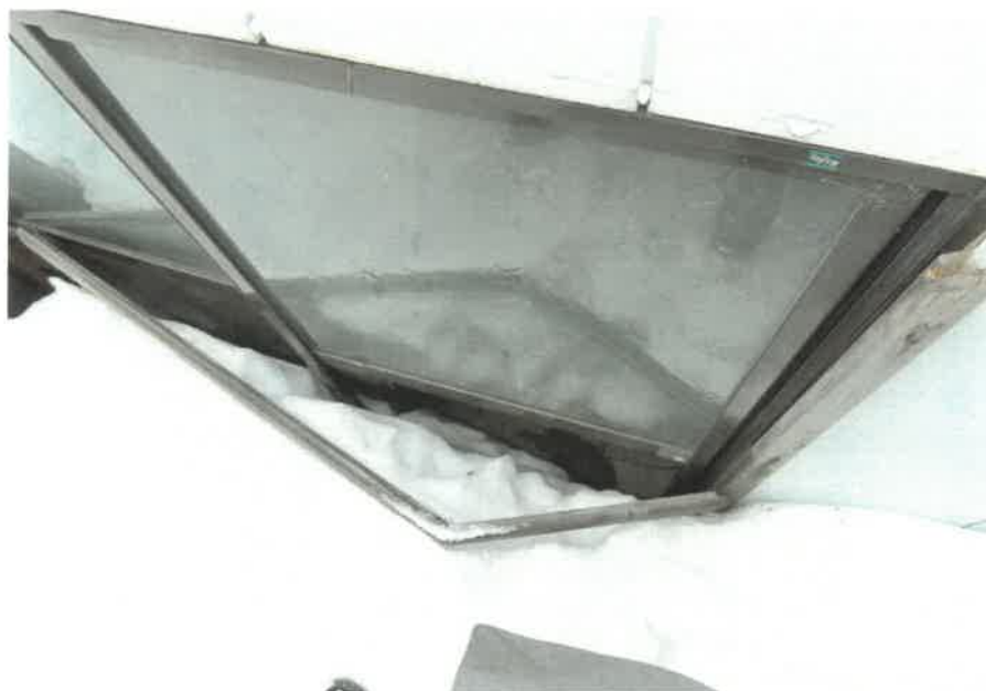
物件2附属建物符号1の入口サッシ戸の状況
