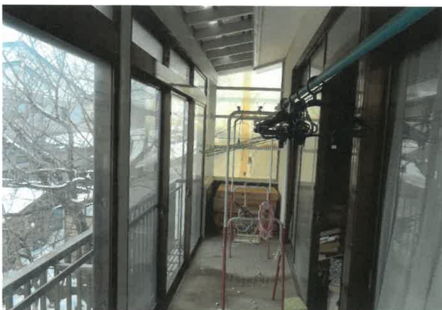
物件2主である建物:2階物干し場の状況
