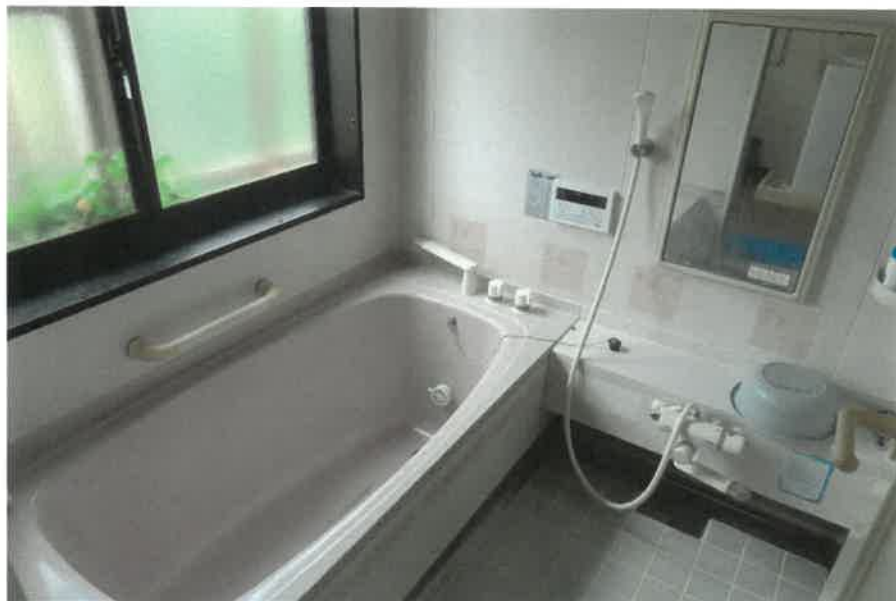
物件2: 1階浴室の状況
