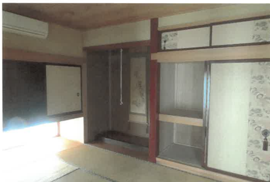
物件2:1階和室2の状況
