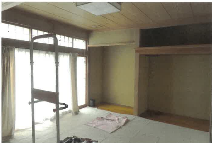
物件2:1階和室1の状況
