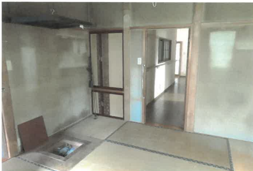
物件2:1階和室3の状況
