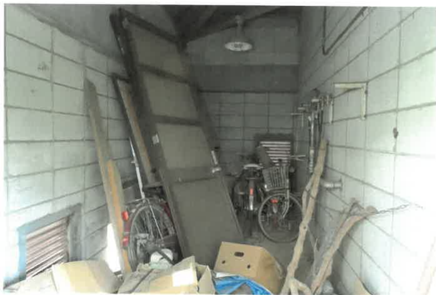
物件23附属建物符号1:1階北西側物置の状況
