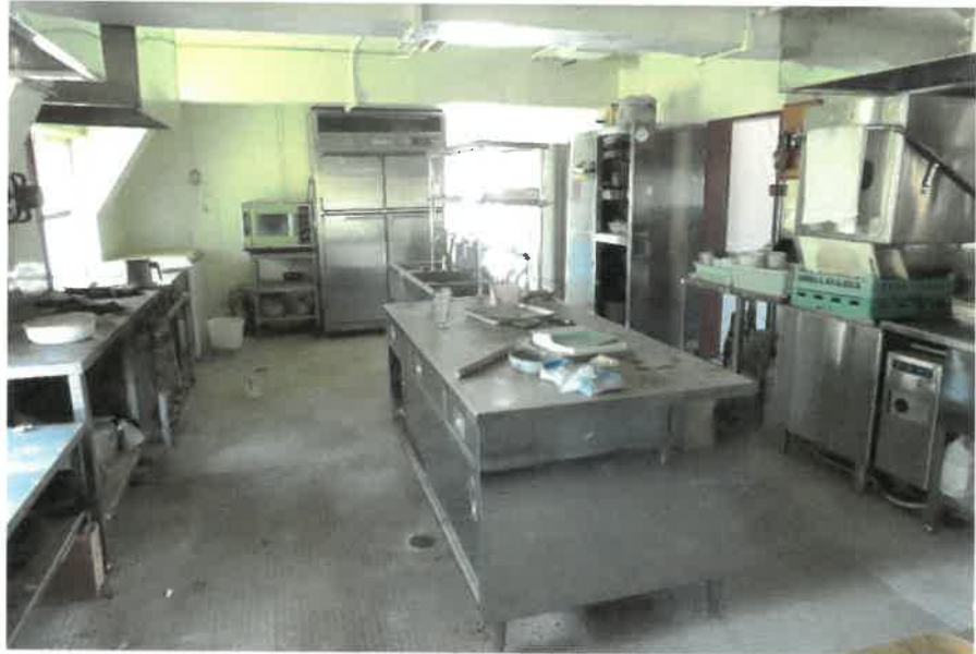
物件23主である建物:1階厨房の状況
