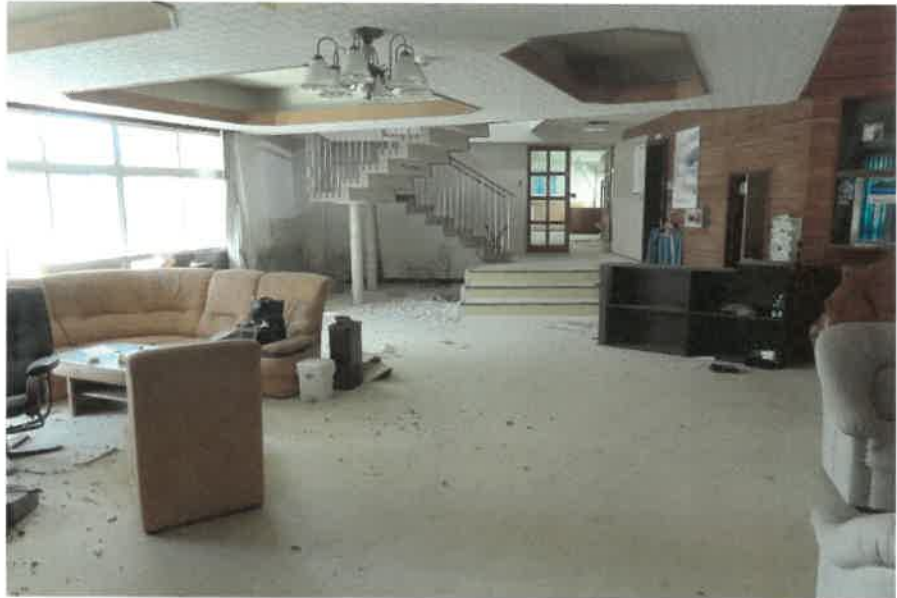
物件23主である建物:1階ホールの状況
