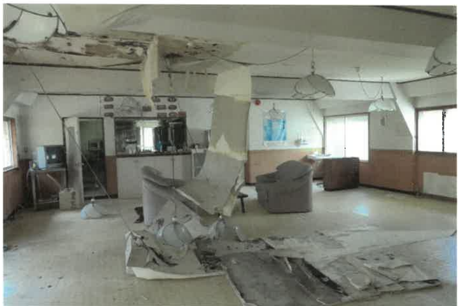
物件23主である建物:1階食堂の状況
