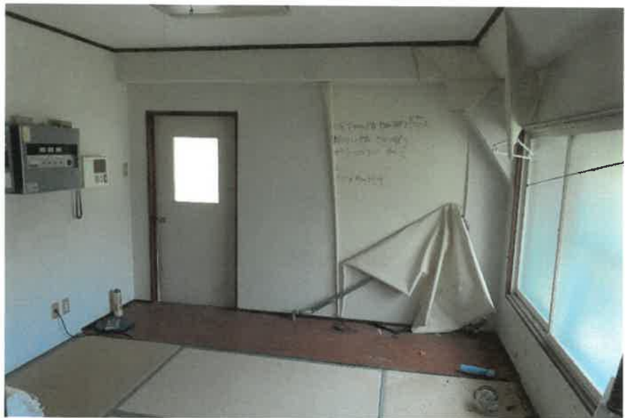
物件23主である建物:1階管理人室の状況
