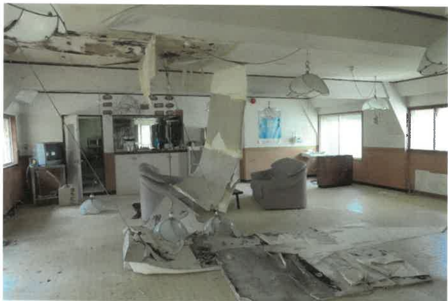
物件23主である建物:1階食堂の状況
