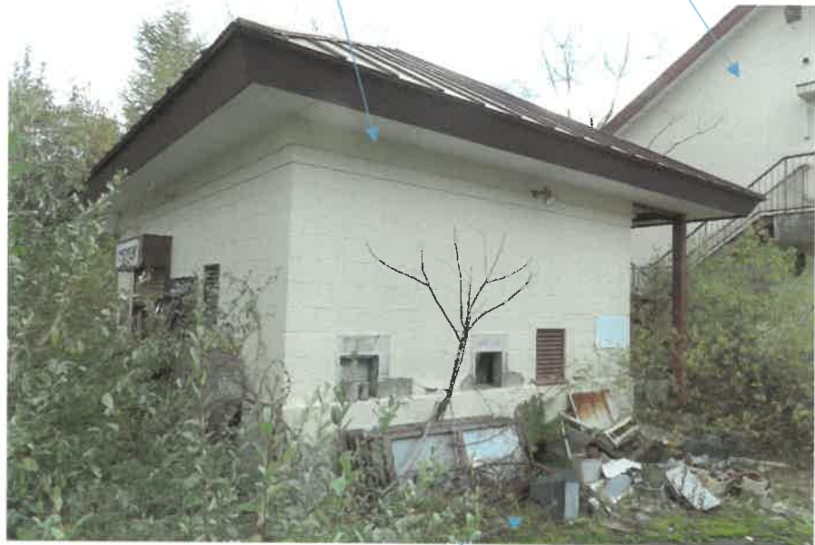
物件23主である建物
