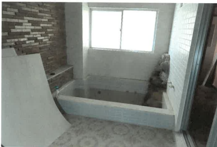
物件23主である建物:1階男子浴室の状況
