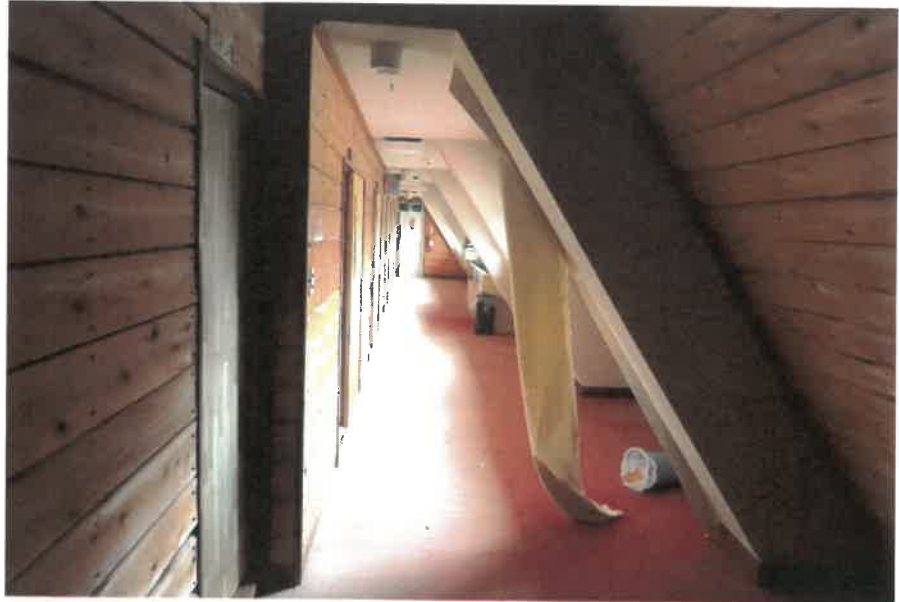
物件23主である建物:2階21号室等前廊下の状況
