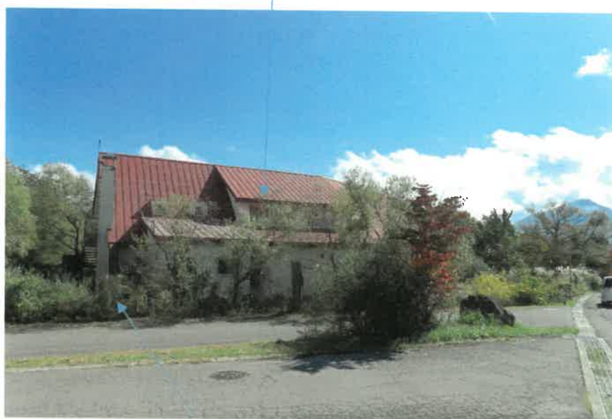
物件23主である建物
