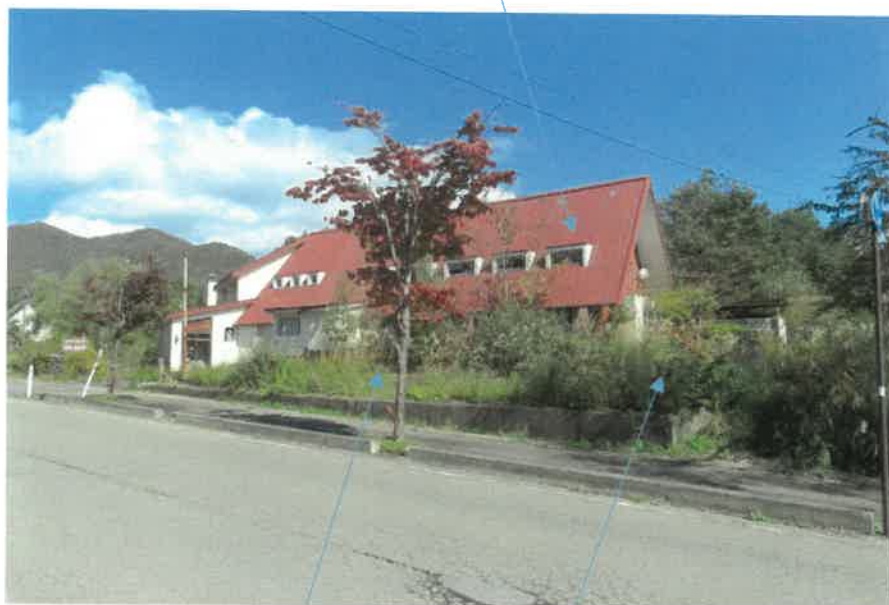
物件23主である建物
