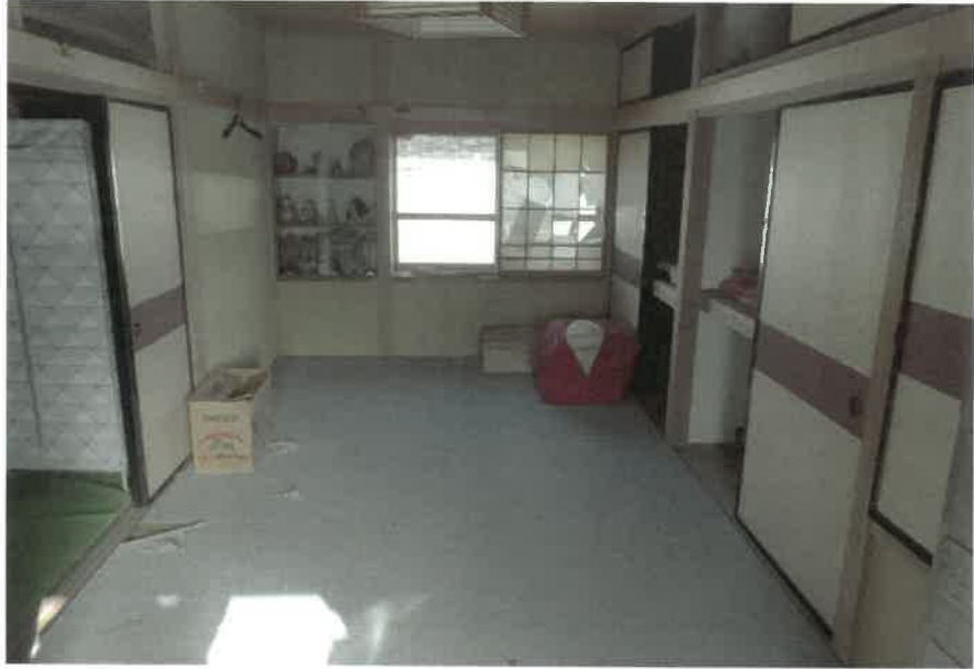
物件2:2階東側和室の状況
