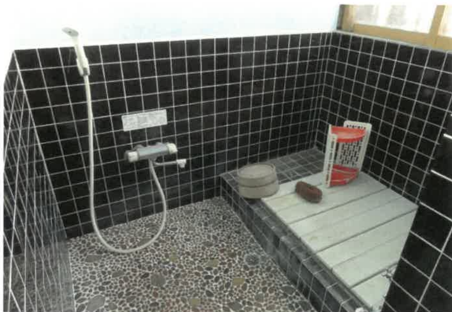
物件2:1階浴室の状況
