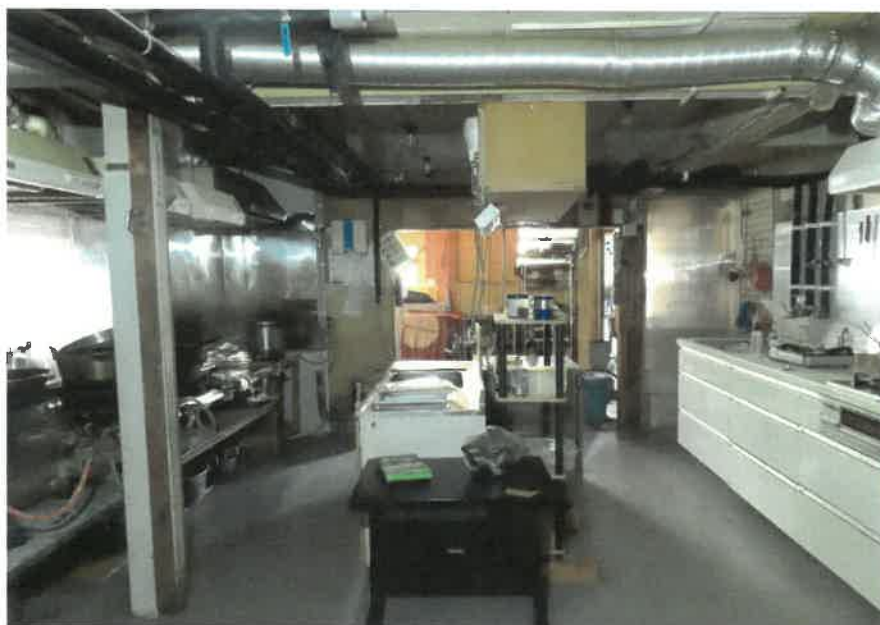
物件3:1階厨房の状況
