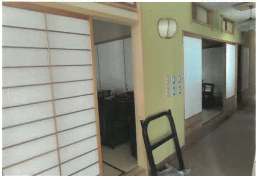
物件3・4:建物の合体状況
