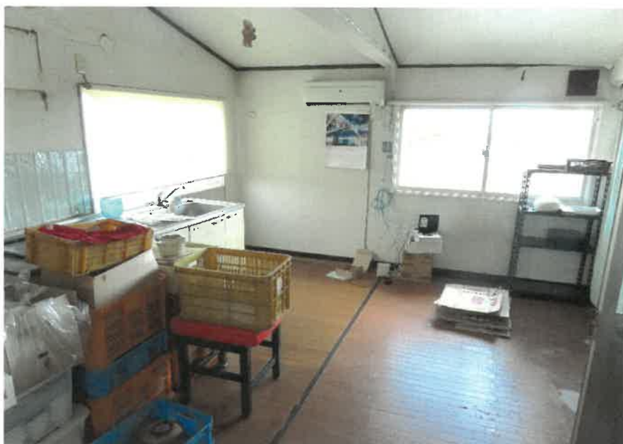
物件4:3階台所の状況
