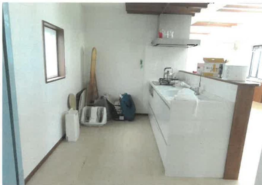
物件3:2階台所(中央南側)の状況
