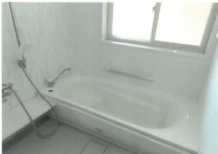
物件3:浴室(北側)の状況
