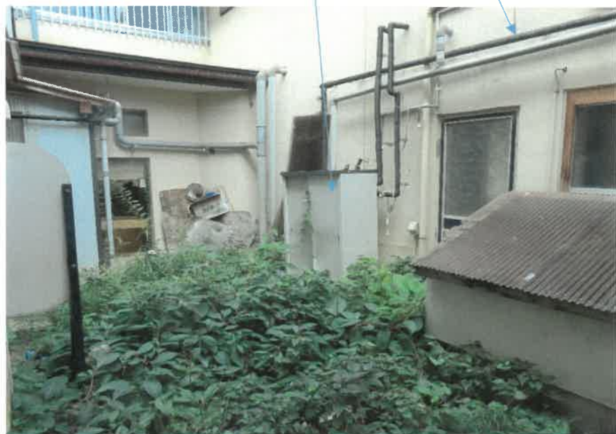
物件3・4:中庭の状況
