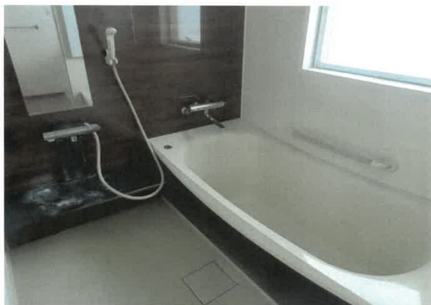
物件3:2階浴室(中央)の状況
