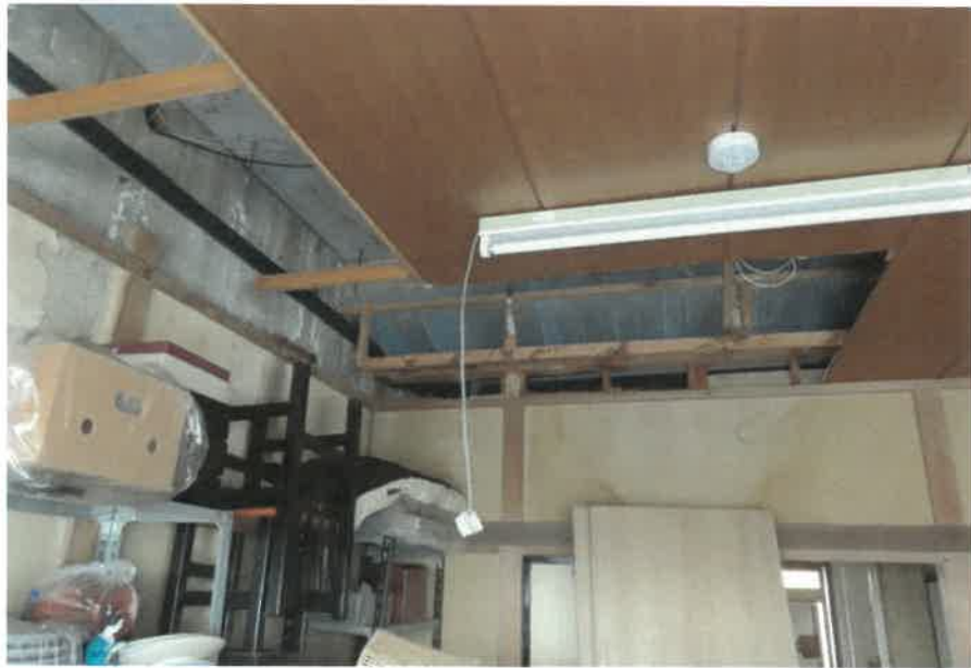
物件4:2階和室(22)の状況
