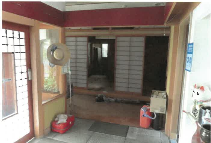
物件3・4:建物の合体状況
