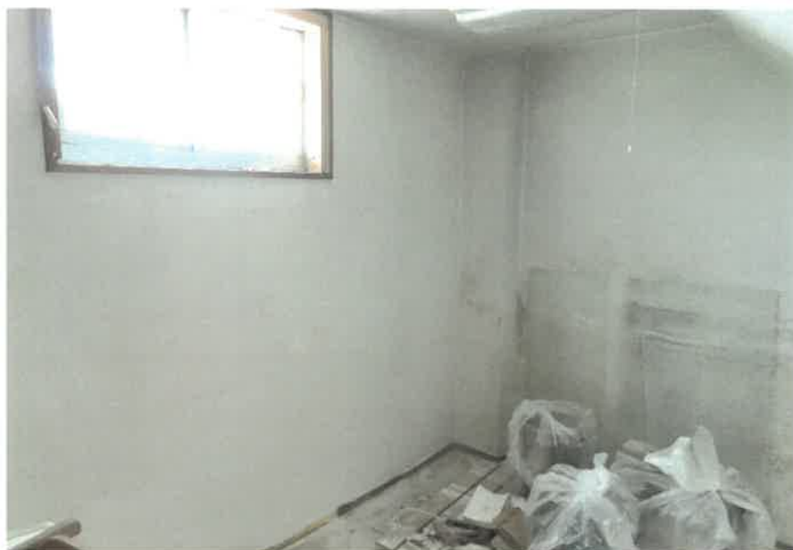
物件4:1階作業場の状況
