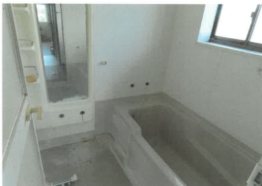
物件4:3階浴室の状況
