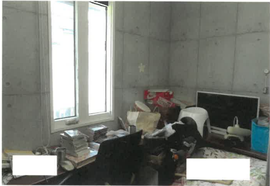
物件3:2階北側洋室の状況
