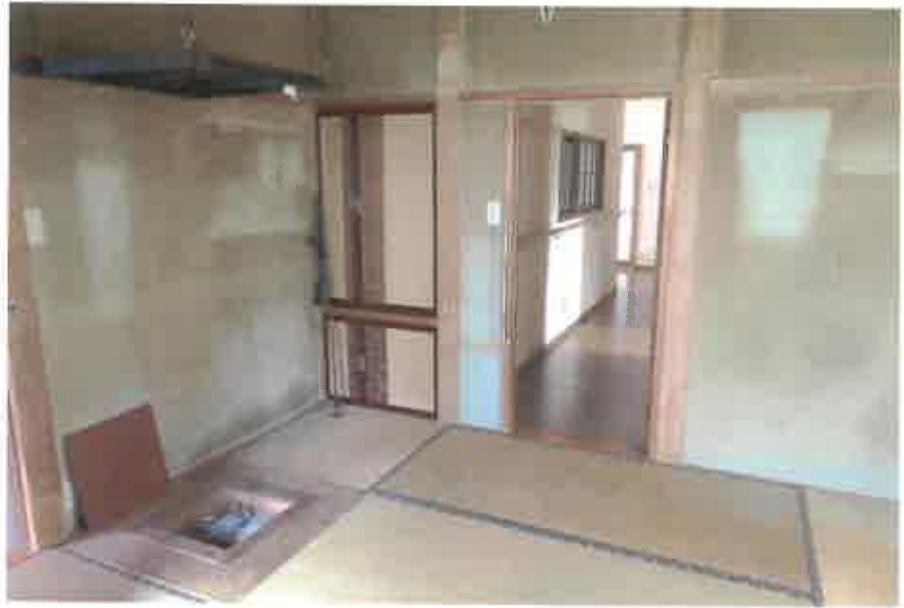
物件2:1階和室3の状況
