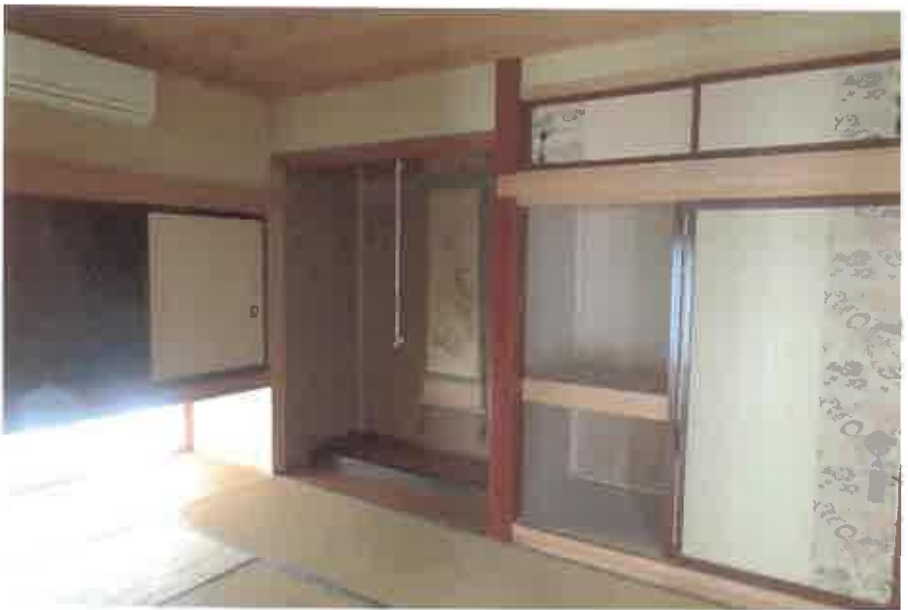
物件2:1階和室2の状況
