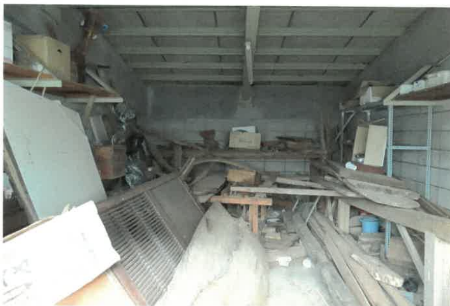
物件23附属建物符号2:物置の状況
