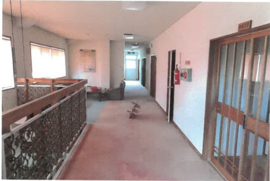
物件23主である建物:2階和室前廊下の状況
