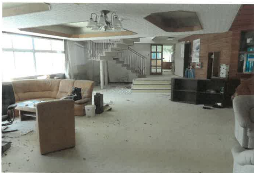
物件23主である建物:1階ホールの状況
