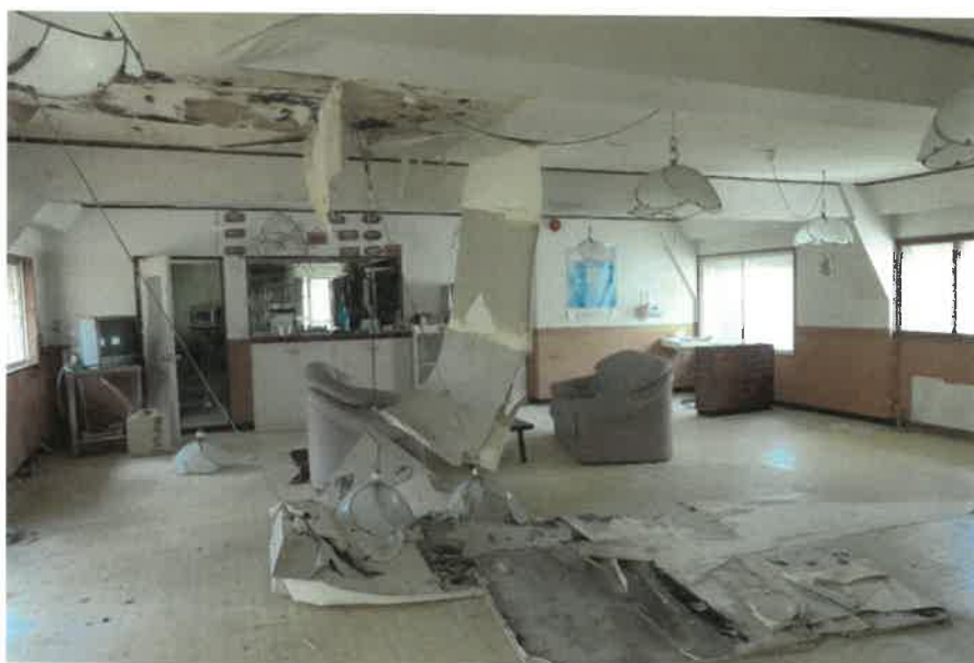
物件23主である建物:1階食堂の状況
