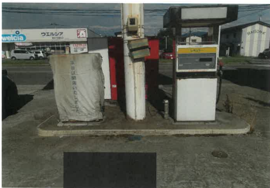
物件1:北東側給油機の状況
