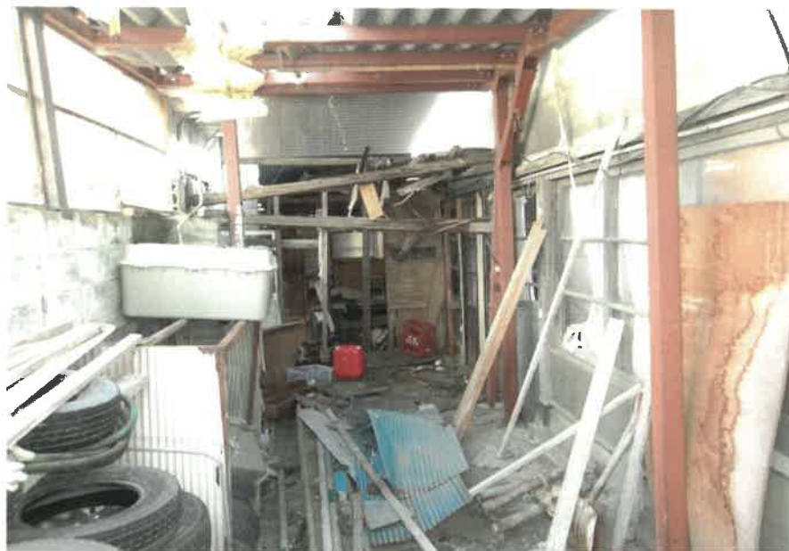
目的外建物:主である建物下屋部分内部の状況
