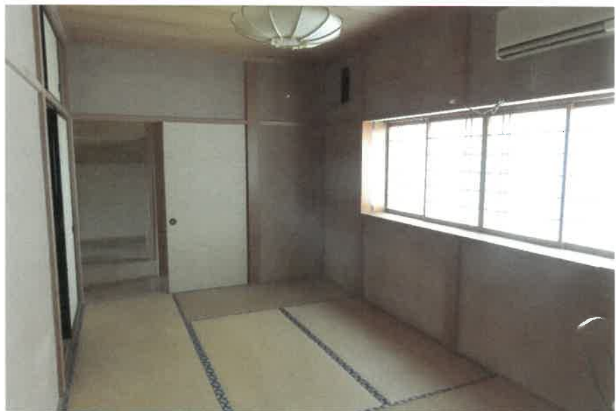
物件4:2階和室⑤の状況
