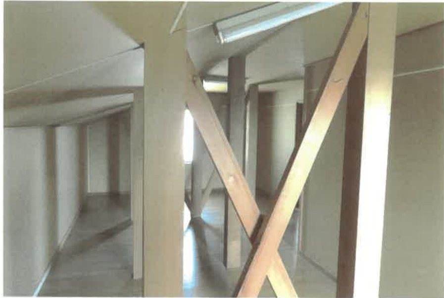
物件4:2階物置(屋根裏部屋)の状況
