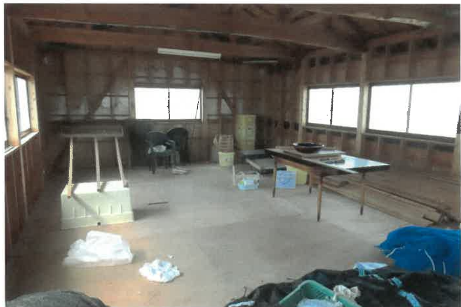
物件5附属建物符号1:2階倉庫の状況
