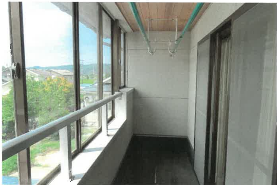
物件4:2階サンルームの状況
