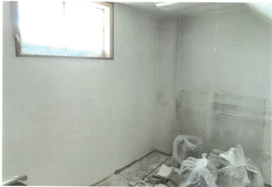
物件4:1階作業場の状況
