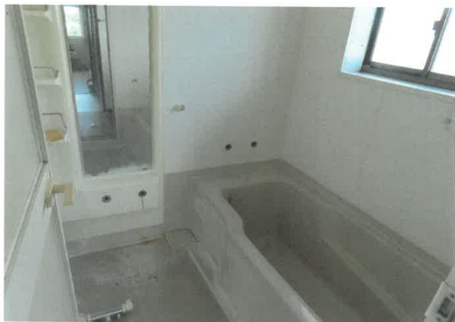
物件4:3階浴室の状況
