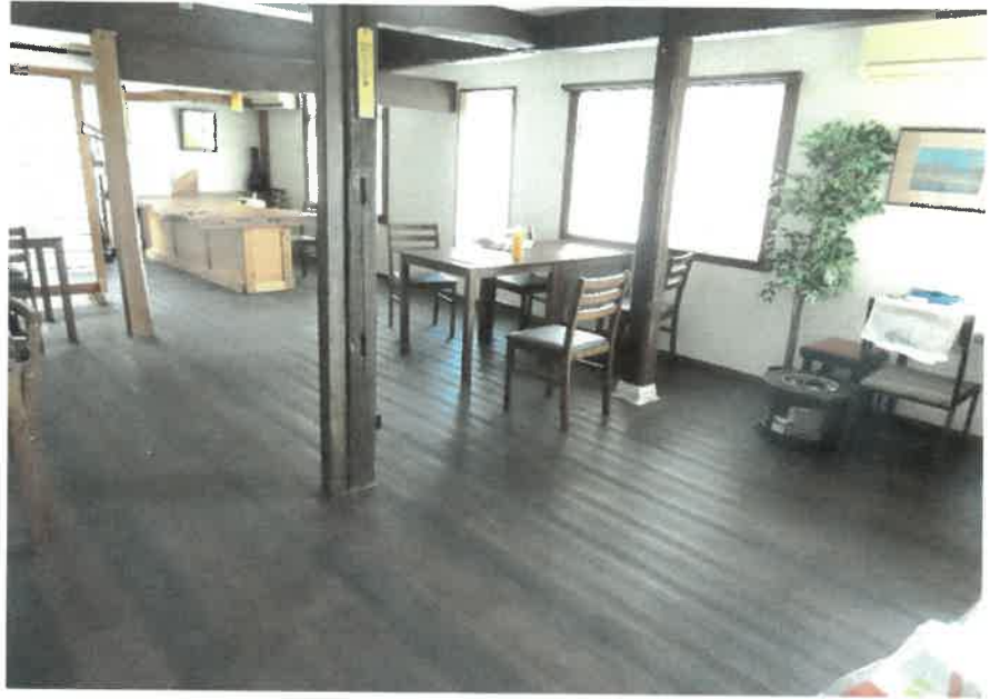
物件3:1階店舗の状況
