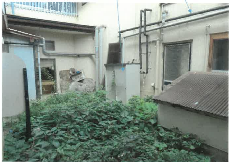
物件3・4:中庭の状況
