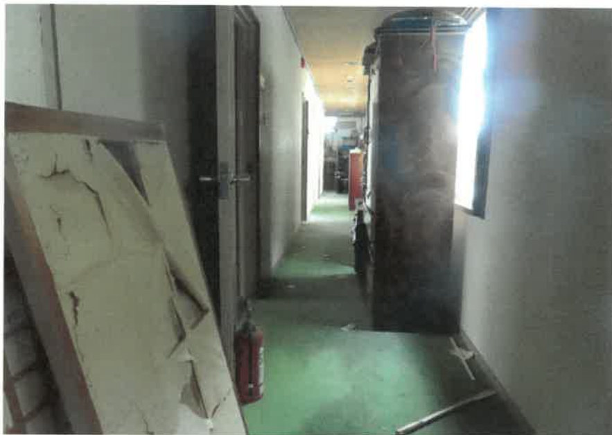
物件4:2階各和室前廊下の状況
