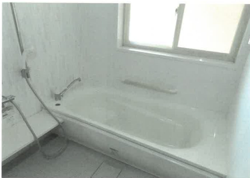
物件3:浴室(北側)の状況
