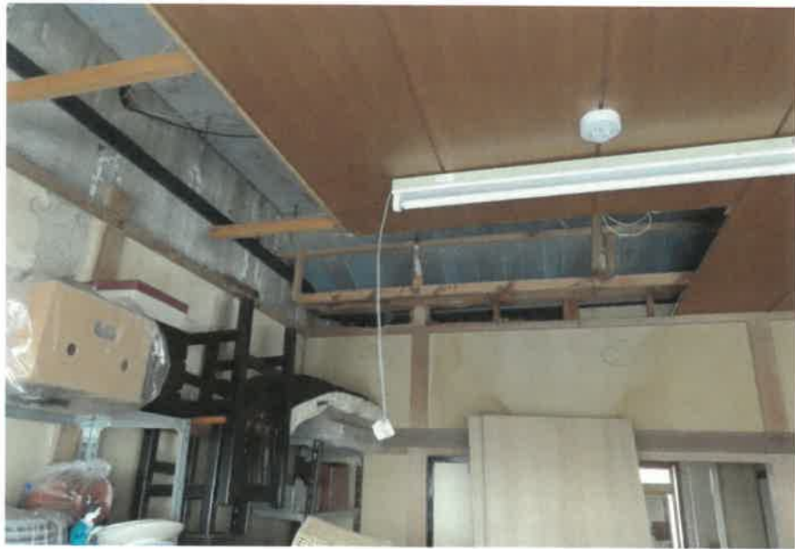
物件4:2階和室(22)の状況
