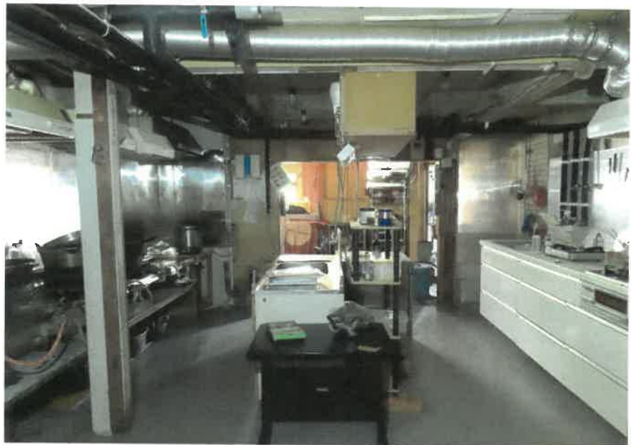
物件3:1階厨房の状況
