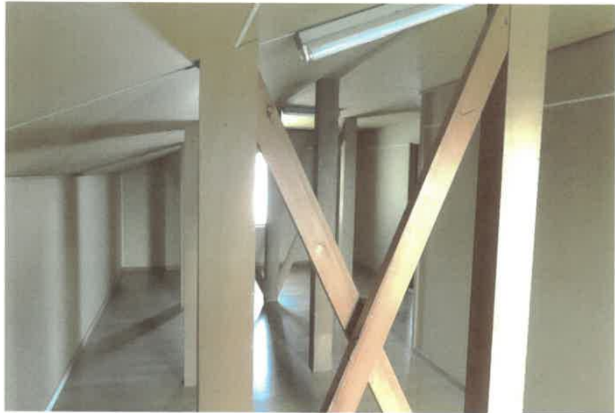
物件4:2階物置(屋根裏部屋)の状況
