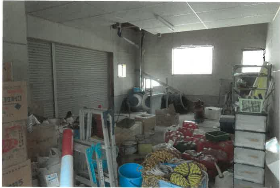
物件5主である建物: 1階南側倉庫の状況
