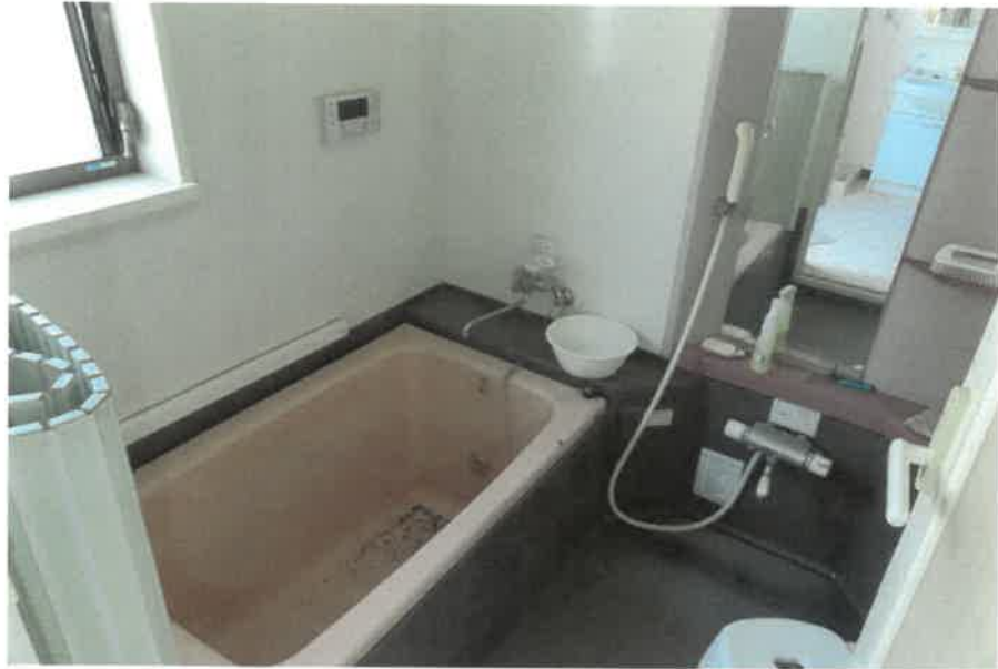
物件4:1階浴室の状況
