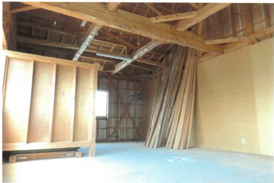
物件5主である建物: 2階作業所・閉鎖された空間の状況
