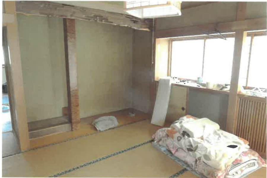
物件4:1階和室①の状況
