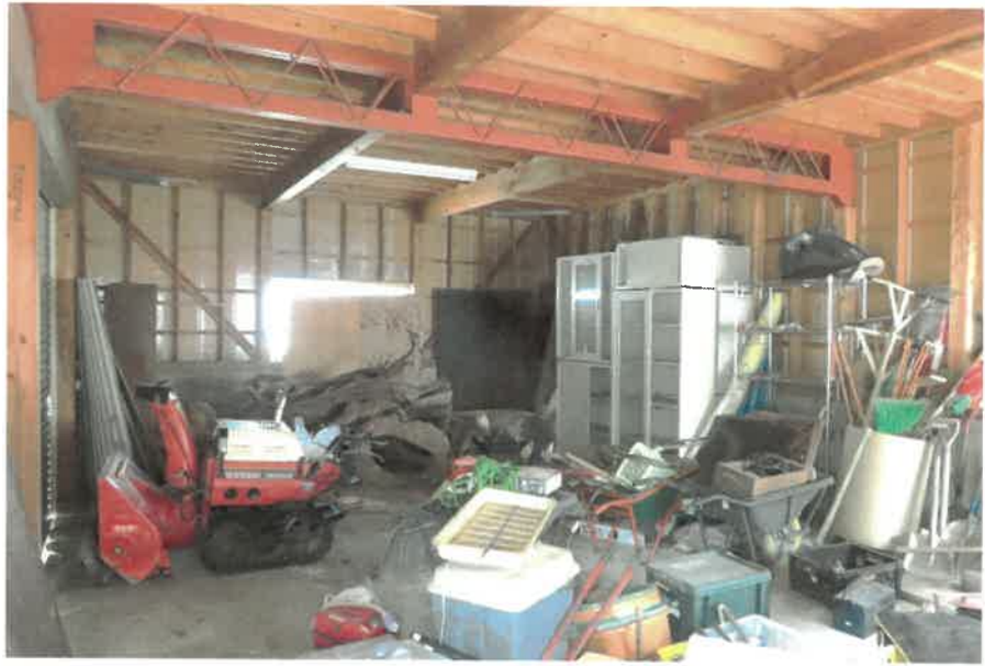
物件5附属建物符号1:1階車庫の状況
