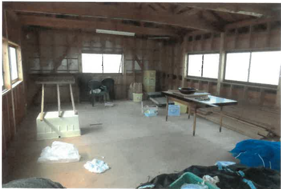
物件5附属建物符号1:2階倉庫の状況
