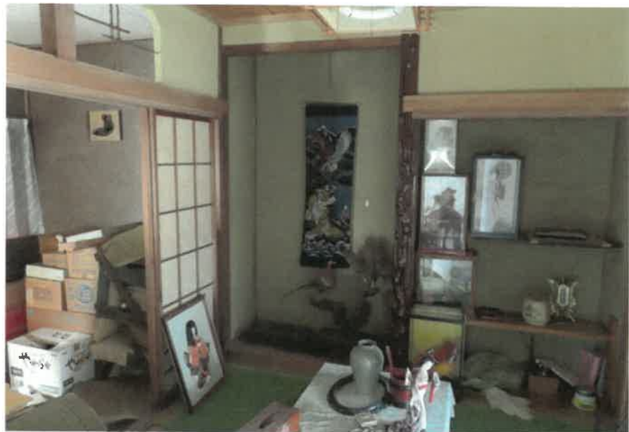
物件2:2階西側和室・南側洋室の状況
