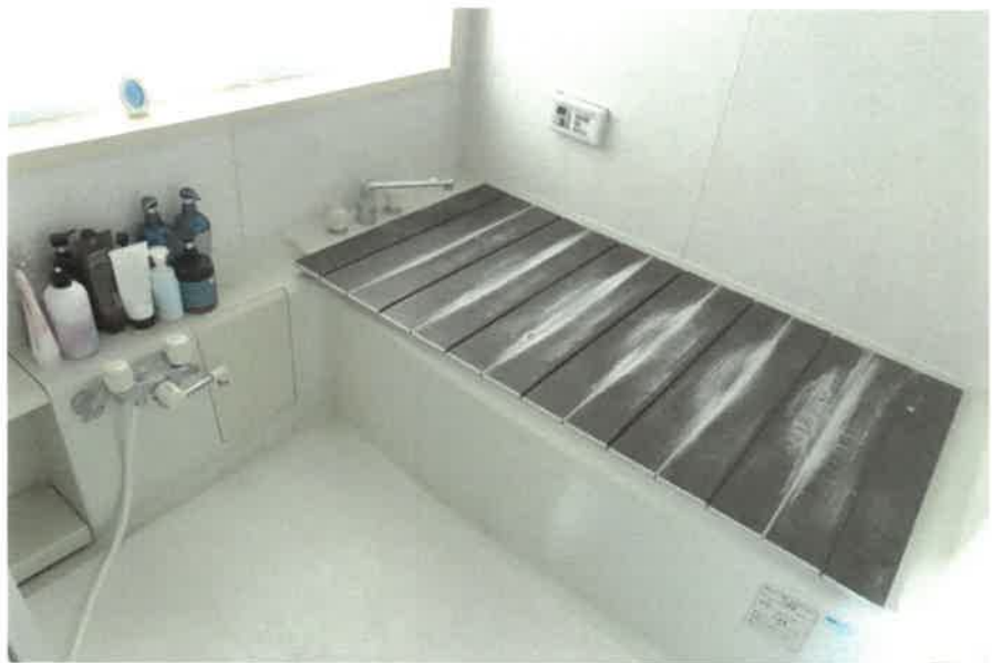
物件2:1階浴室の状況
