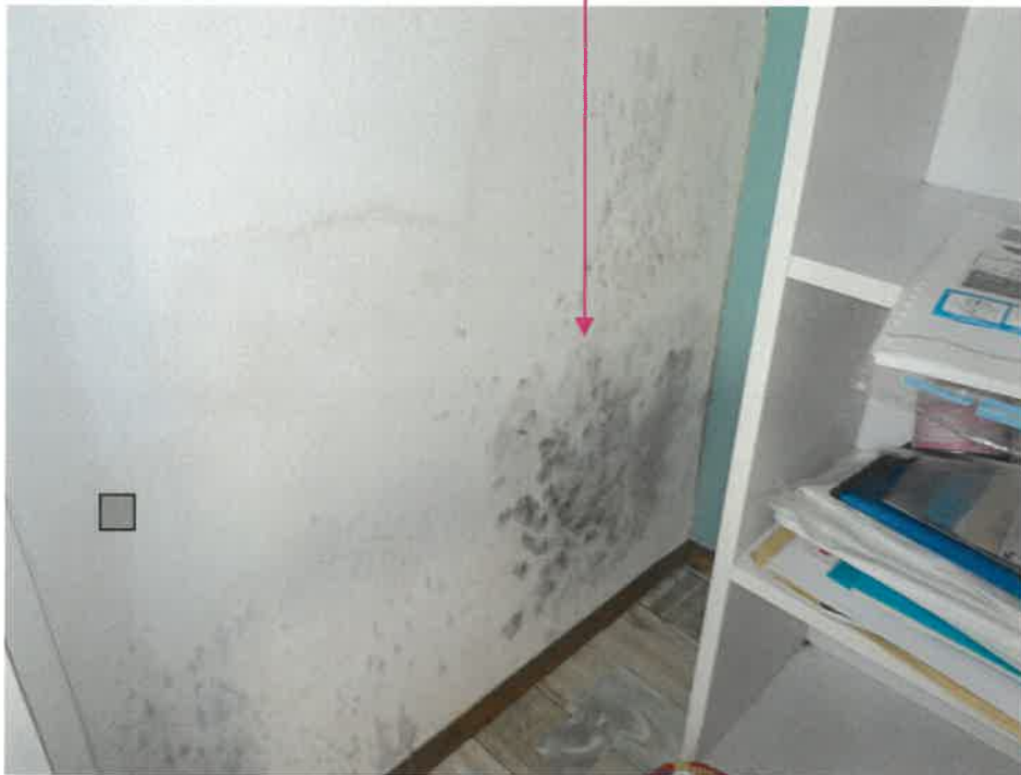
物件2:2階物入の壁のしみ
