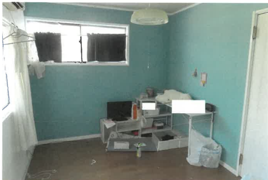
物件2:2階北側洋室の状況
