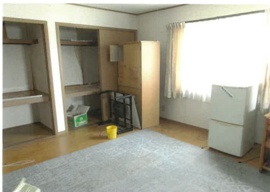
物件5主である建物:2階洋室の状況
