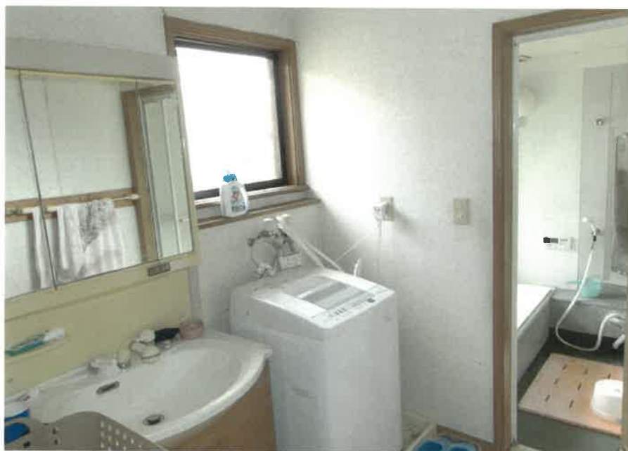
物件5主である建物:1階洗面所の状況
