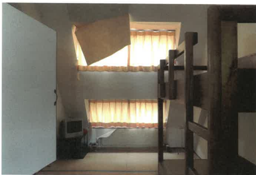
物件23主である建物:2階23号室の状況
