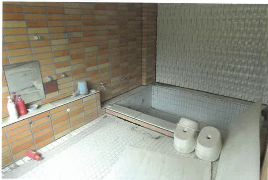
物件23主である建物:1階女子浴室の状況
