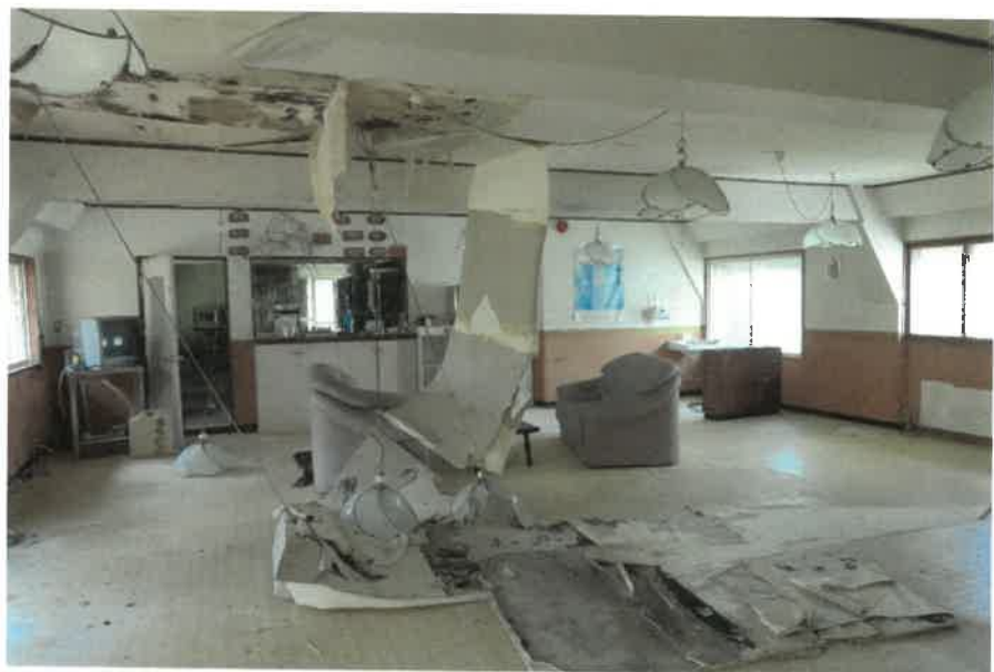
物件23主である建物:1階食堂の状況
