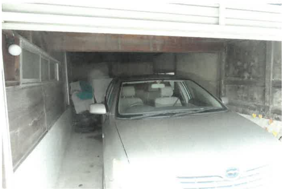
物件4主である建物:1階車庫の状況
