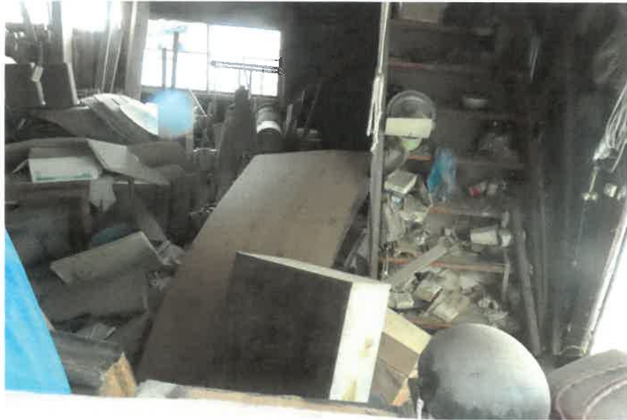
物件4未登記附属建物:1階内部の状況
