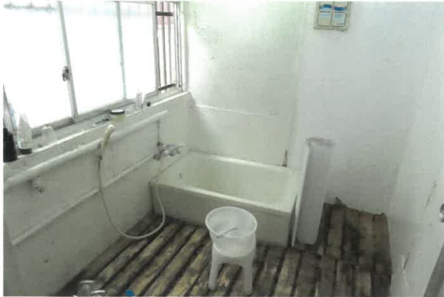
物件4主である建物:1階浴室の状況
