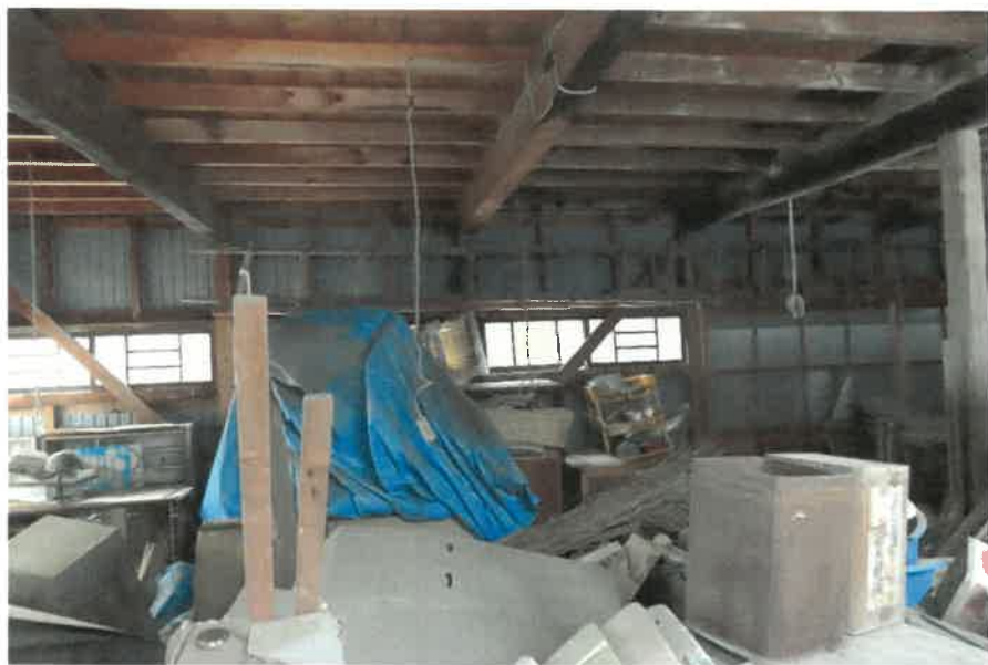
物件4未登記附属建物:1階内部の状況
