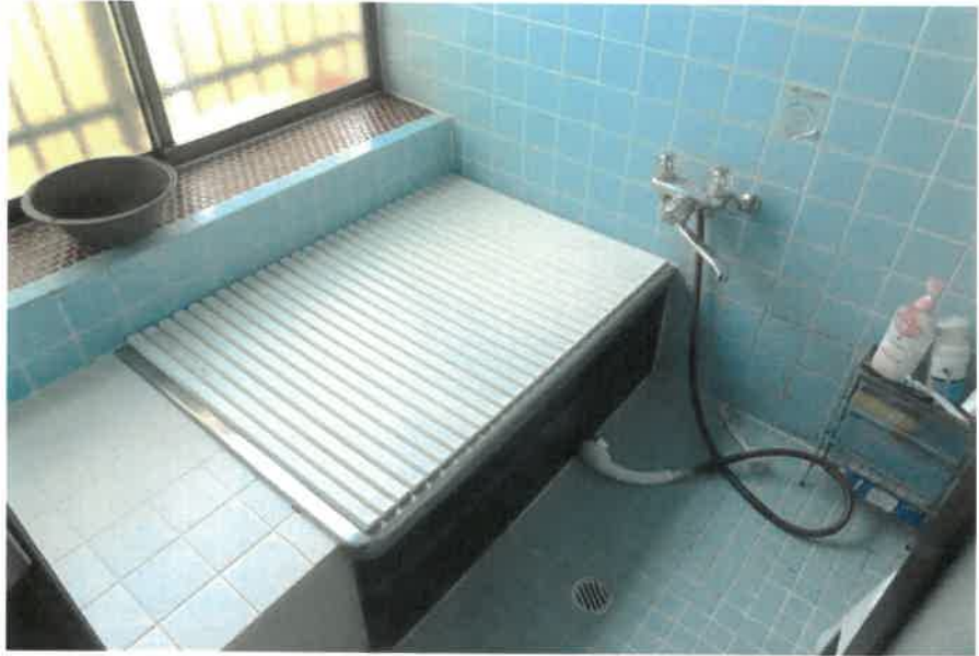
物件2主である建物: 1階浴室の状況
