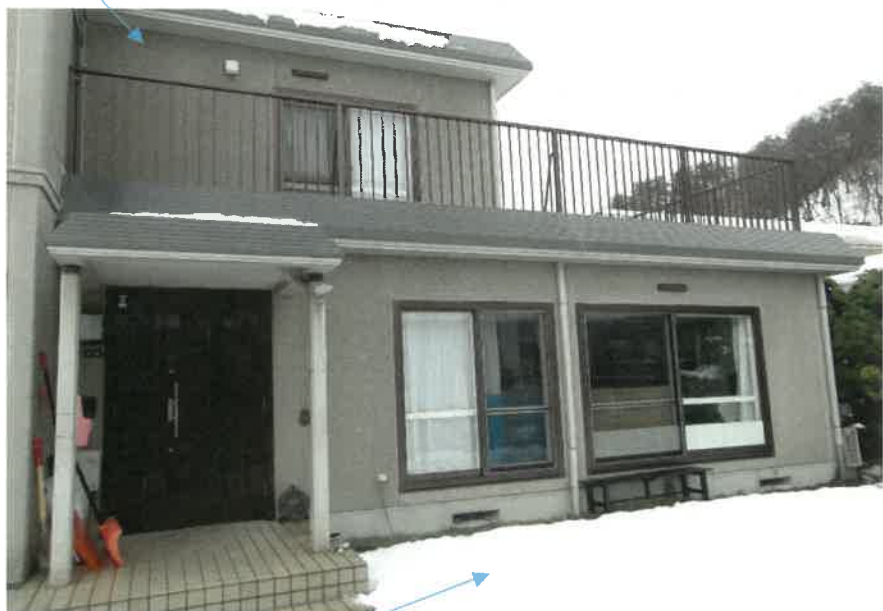
物件9主である建物
