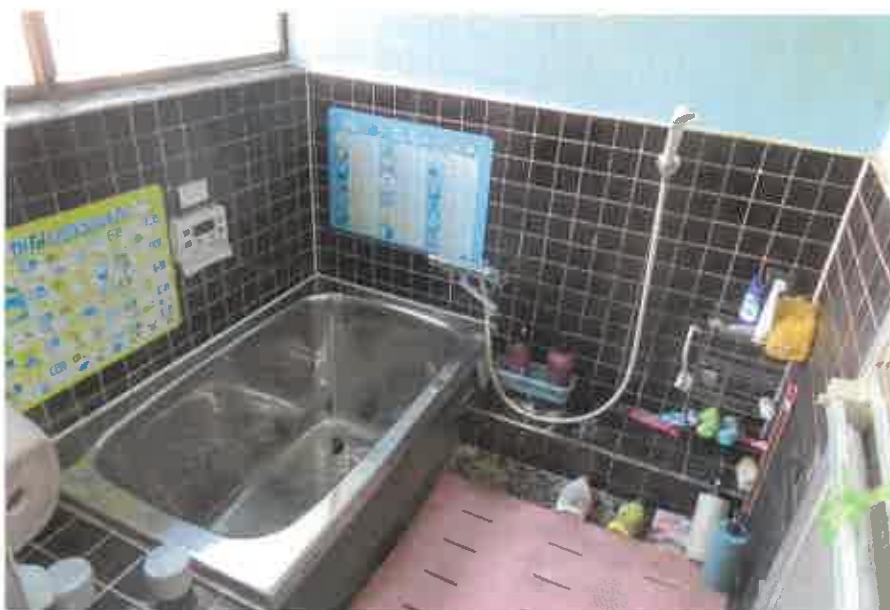
物件2主である建物:1階浴室の状況
