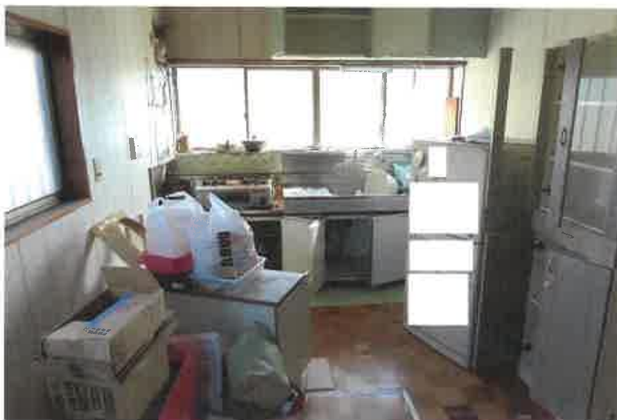
物件2主である建物:1階台所の状況
