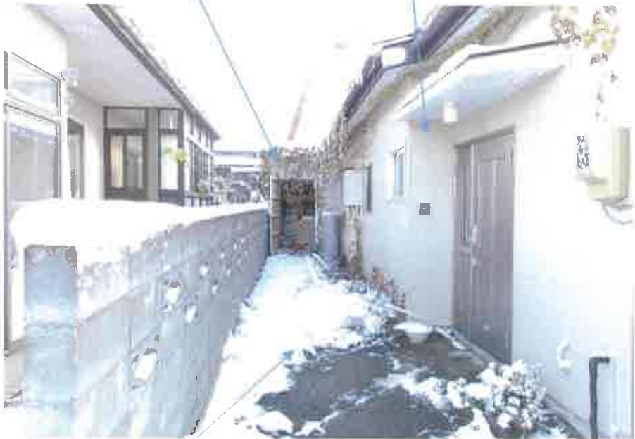
物件3主である建物
