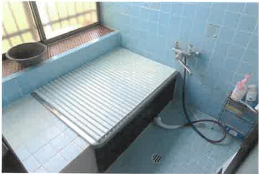
物件2主である建物:1階浴室の状況
