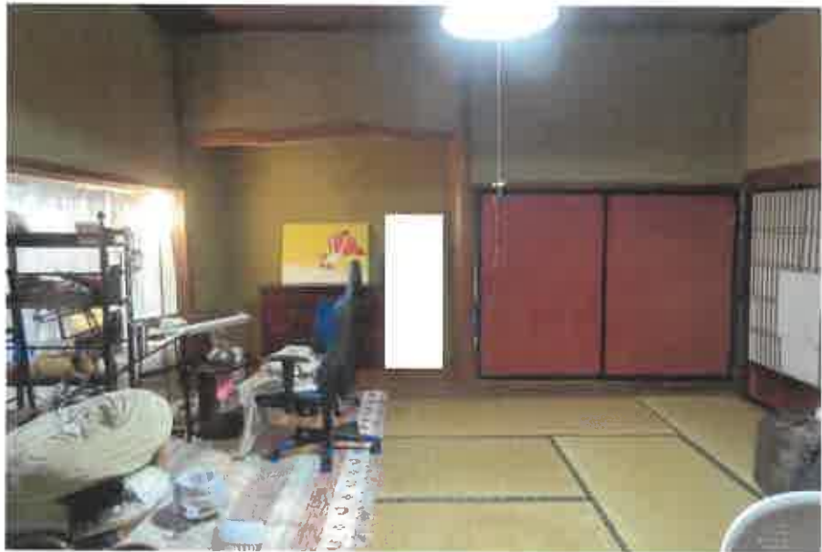
物件4主である建物:1階東側和室の状況
