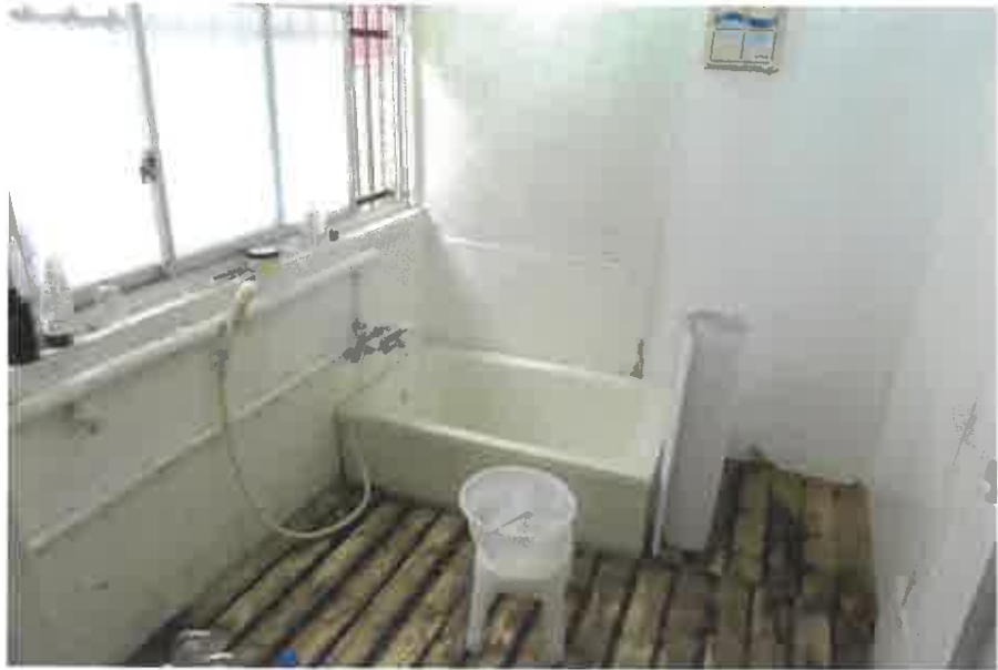
物件4主である建物:1階浴室の状況
