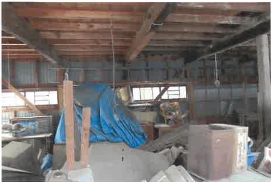
物件4未登記附属建物:1階内部の状況
