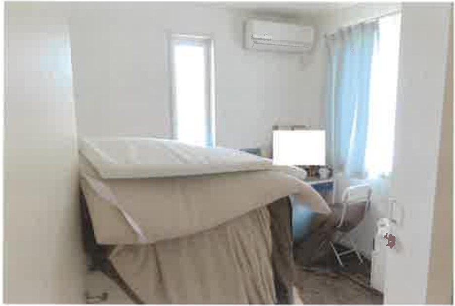
物件3:2階北西側洋室の状況
