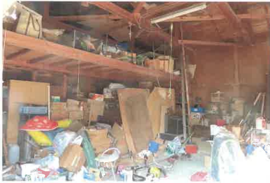
物件3:作業所・㊤棚の状況
