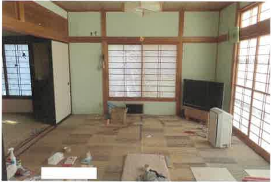
物件2:1階南側和室の状況
