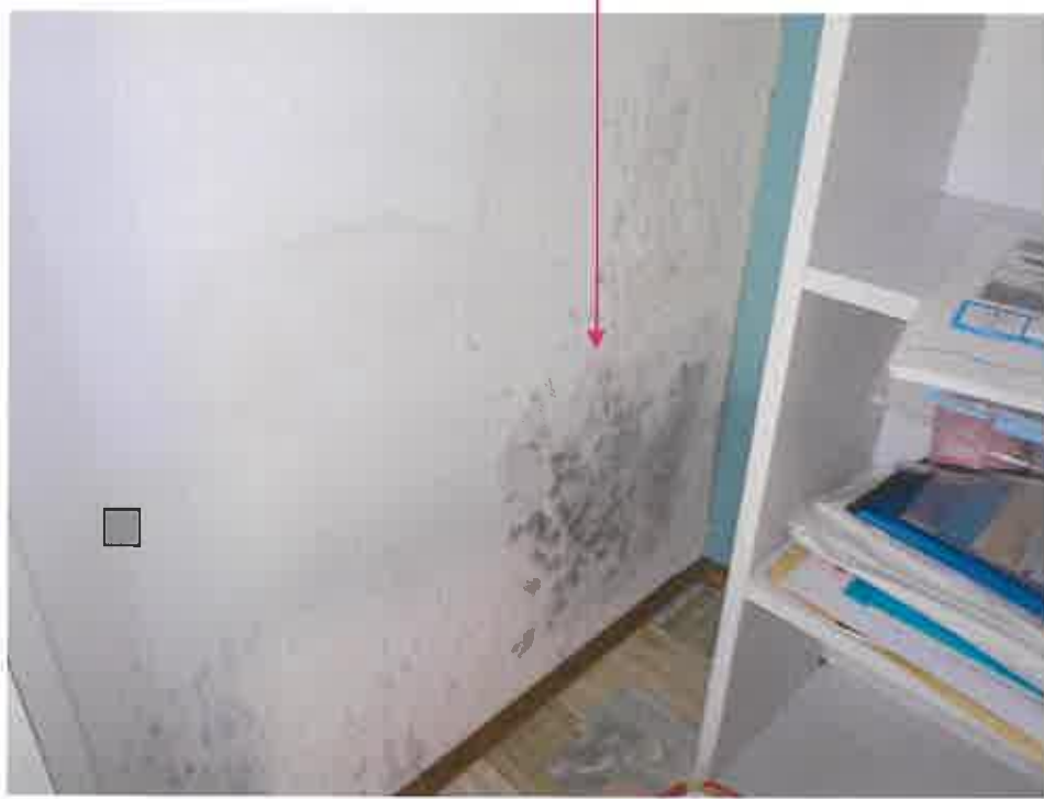
物件2:2階物入の壁のしみ
