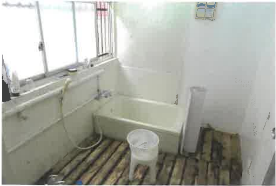
物件4主である建物:1階浴室の状況
