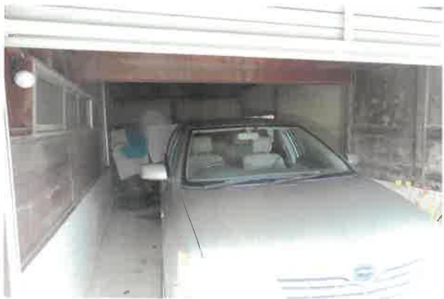
物件4主である建物:1階車庫の状況
