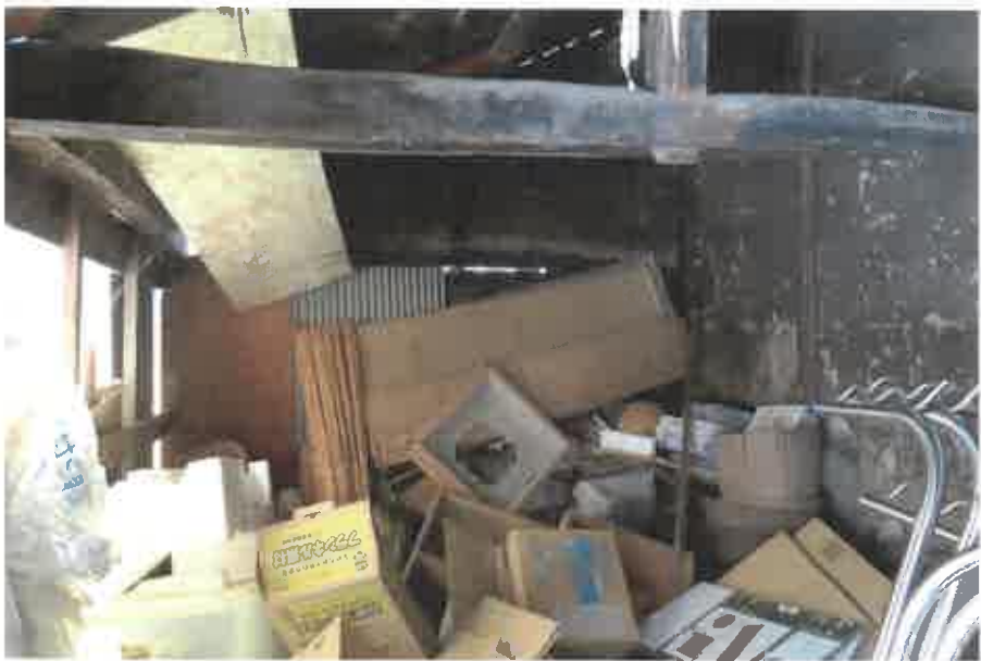
物件4主である建物:1階西側物置の状況
