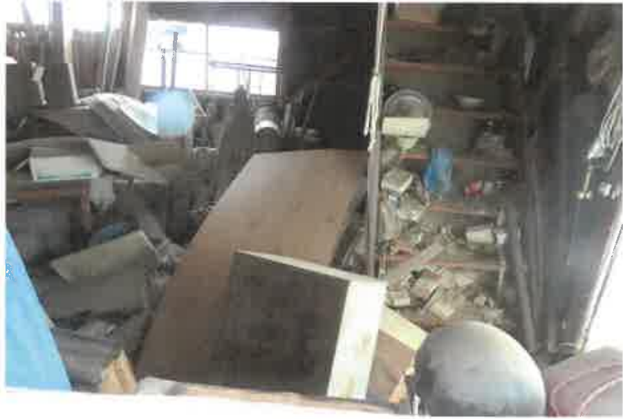
物件4未登記附属建物:1階内部の状況
