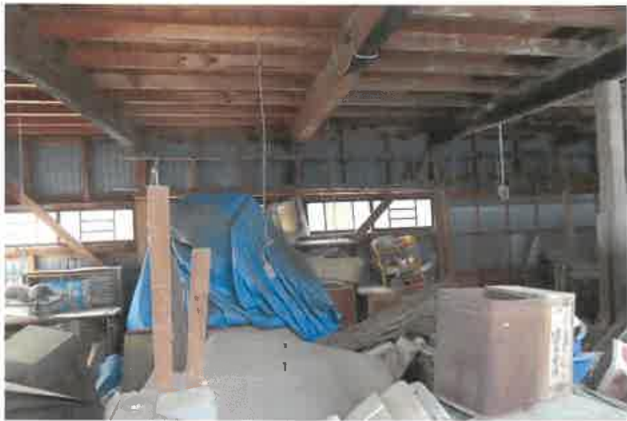
物件4未登記附属建物:1階内部の状況
