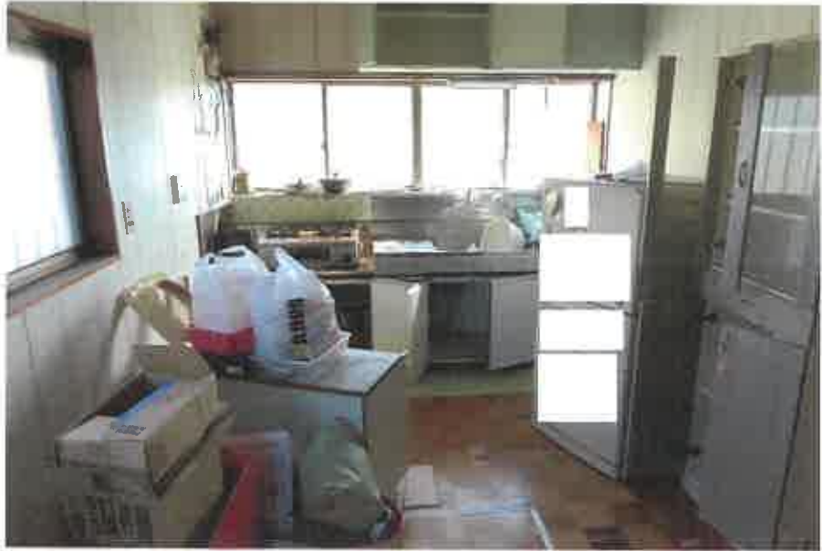
物件2主である建物:1階台所の状況
