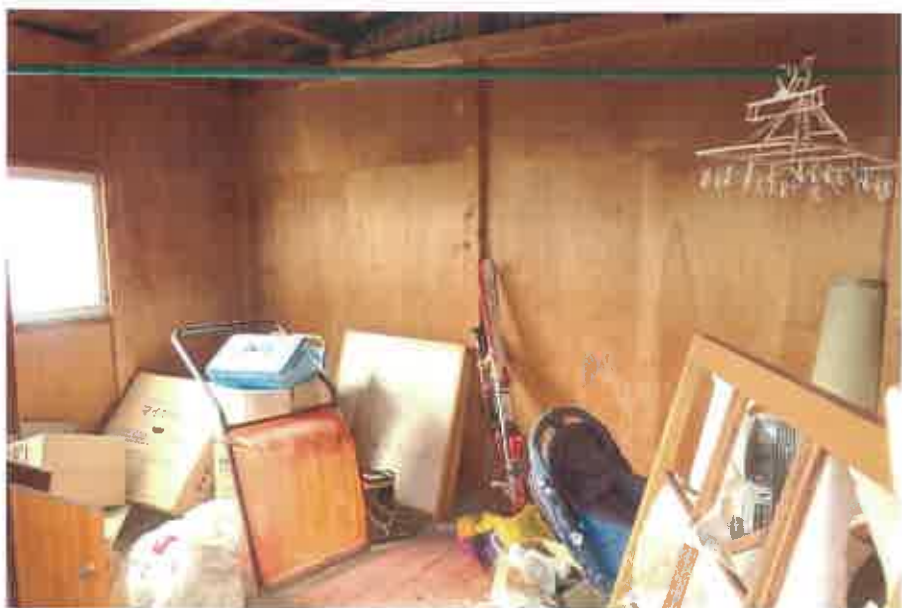
物件2附属建物符号2:内部の状況
