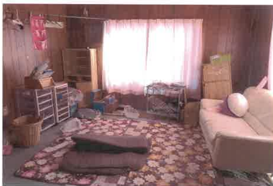
物件2主である建物:1階洋室の状況
