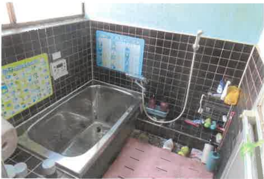
物件2主である建物:1階浴室の状況
