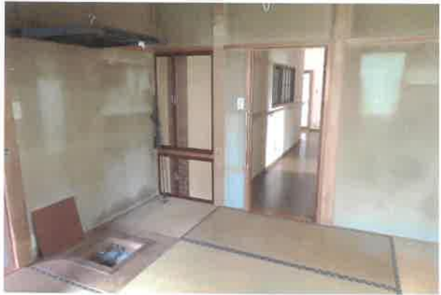
物件2:1階和室3の状況
