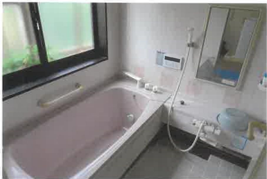
物件2:1階浴室の状況
