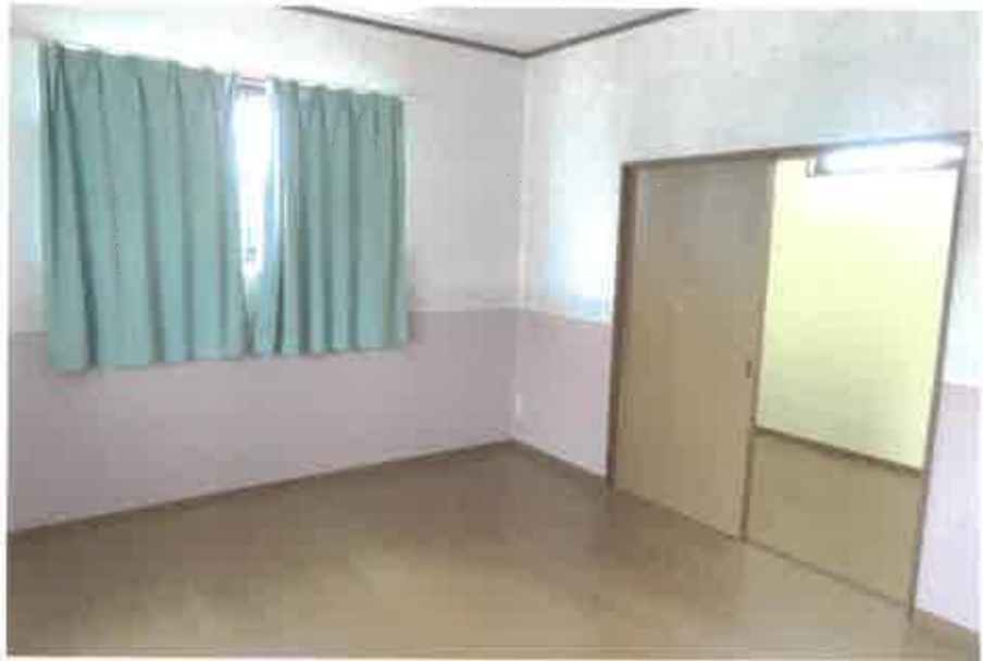
物件2:2階洋間1・納戸の状況
