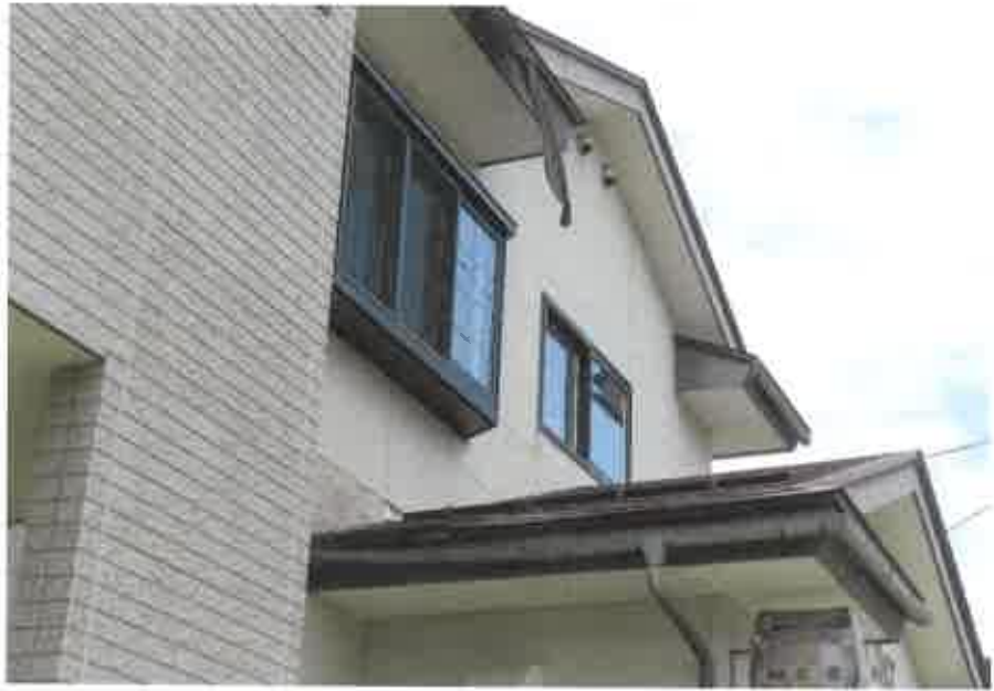
物件2: 店舗の南西側屋根及び南東面外壁の状況
