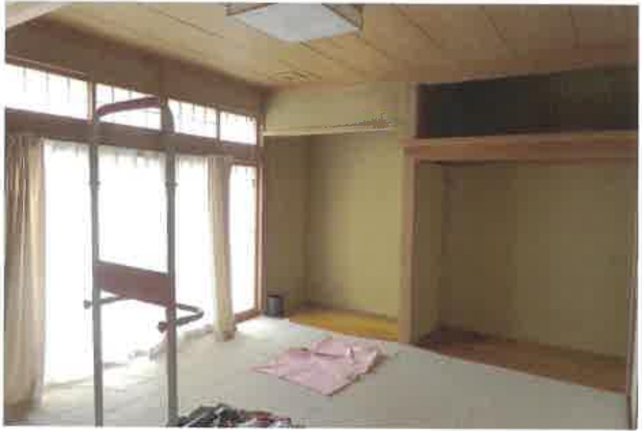
物件2:1階和室1の状況
