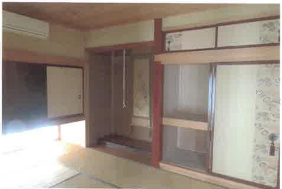
物件2:1階和室2の状況
