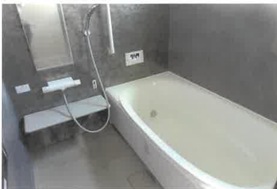
物件2:1階浴室の状況
