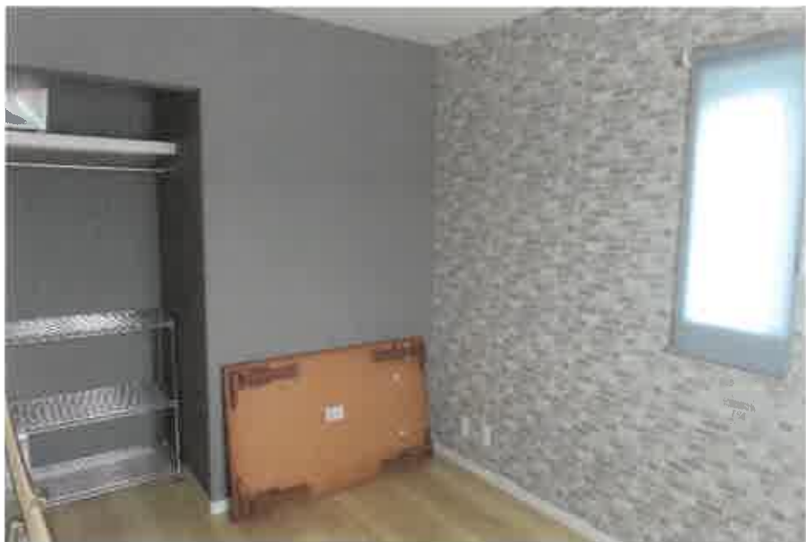
物件2:2階北西側洋室の状況
