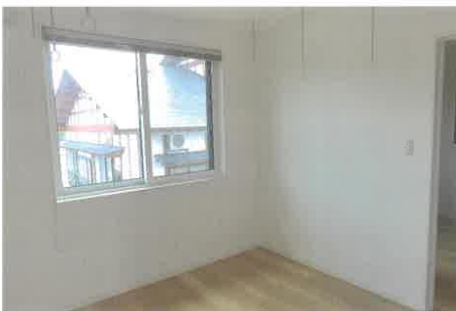
物件2:2階ホールの状況
