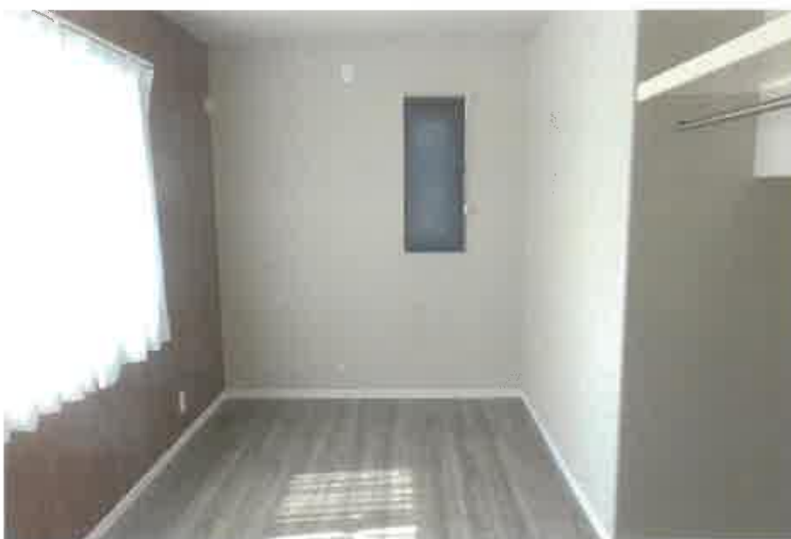
物件2:1階洋室の状況
