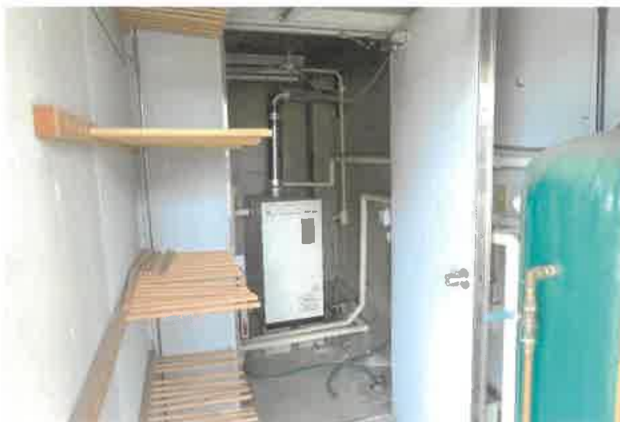
物件2居宅部分:1階ボイラー室の状況
