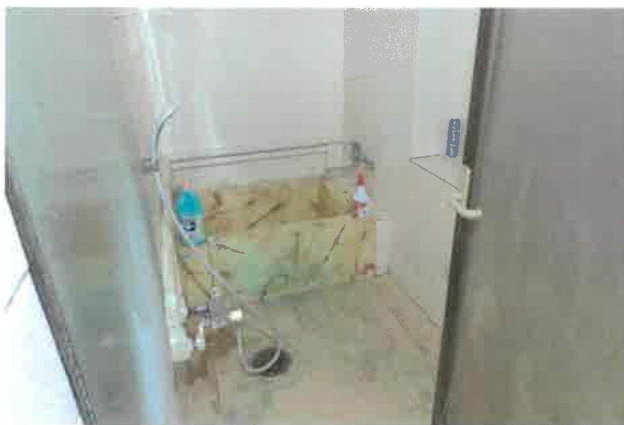
物件2居宅部分:1階浴室の状況
