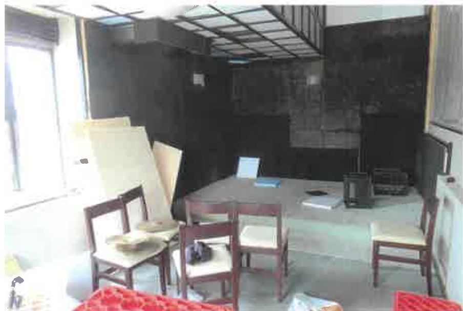
物件3:2階店舗2の状況
