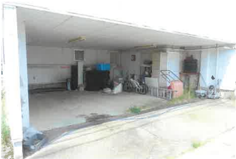
物件2居宅部分:1階車庫の状況
