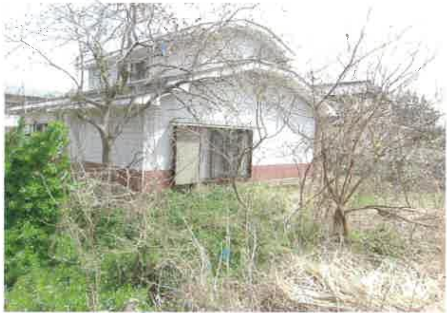
物件2主である建物
