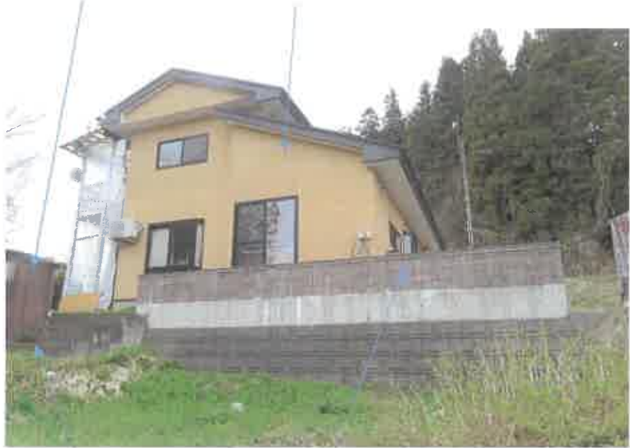
物件3未登記附属建物② 物件3主である建物
