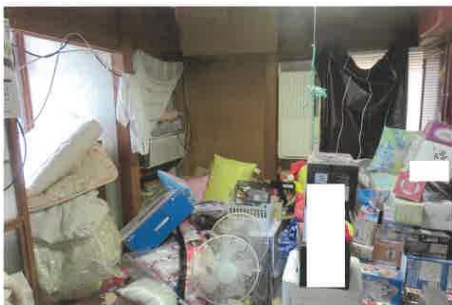
物件2:南側西方和室の状況
