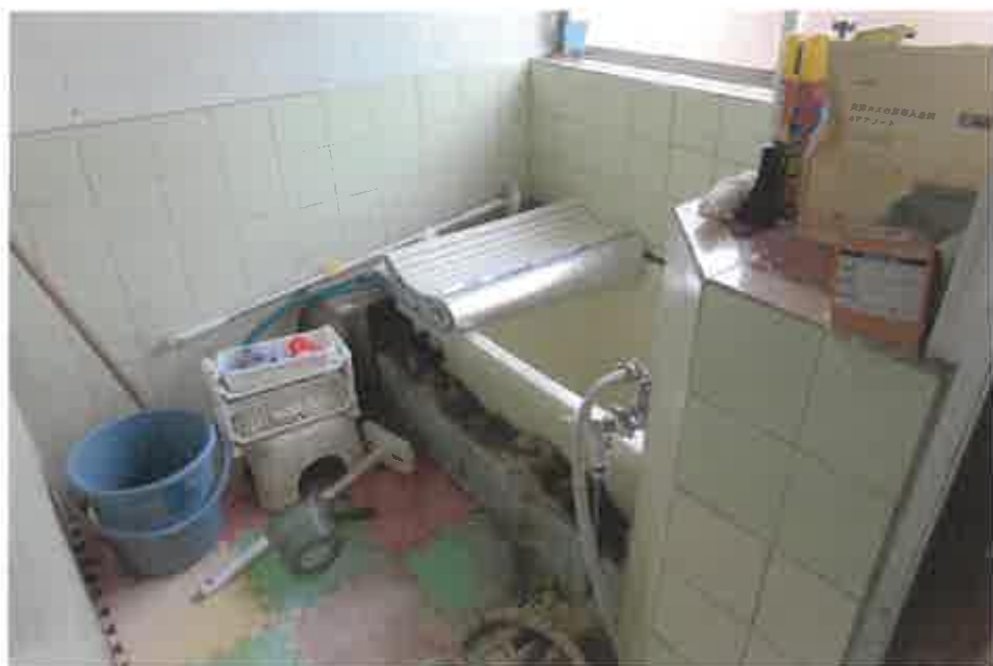
物件2:浴室の状況
